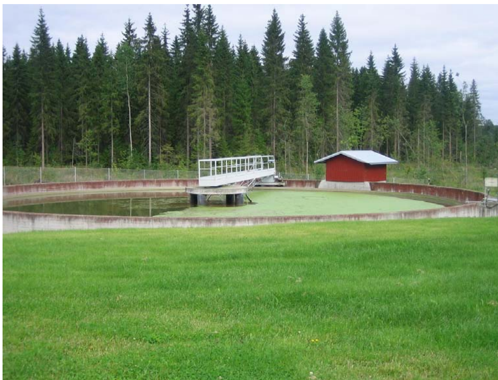
Kuva 7.9. Lapinlahden jätevedenpuhdistamotoiminnot sijoittuvat laajalle ja alueella on runsaasti laajennusvaraa.
