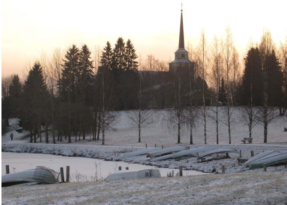
Kuva 7.7. Kiuruveden puhdistamo sijaitsee Kiuruvesijärven rannalla.
