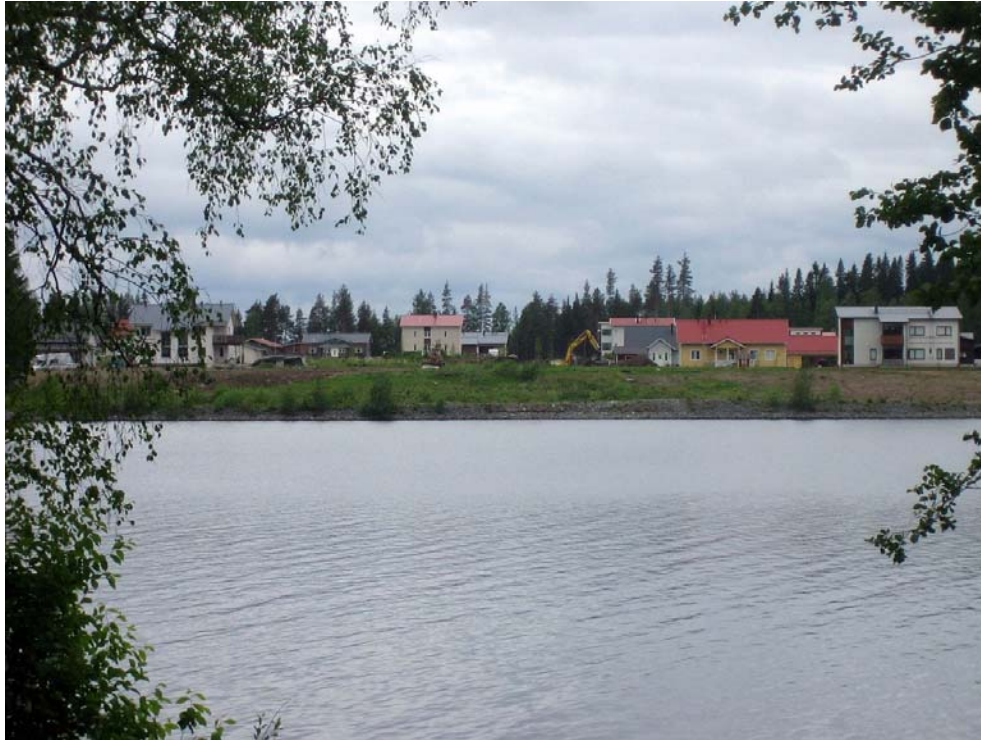
Kuva 7.8. Iisalmen jätevedenpuhdistamo vastapäätä Luuniemeen on rakenteilla uusi asuin-alue.
