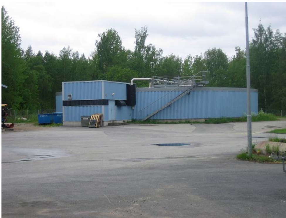
Kuva 7.10. Panimon jätevesien tasausaltaan kompressorin lisälmen jätevedenpuhdistamolla aiheuttaa ympäristöön meluhaittoja.
