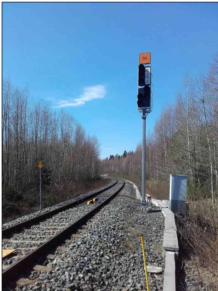
Kuva 5-20. Kipsin läjitysalueen pohjoispuolella kulkevalla Siilinjärvi-Viinijärvi-radalla on ainoastaan tavaraliikennettä (kuva: P. Hertteli 4.5.2016).
