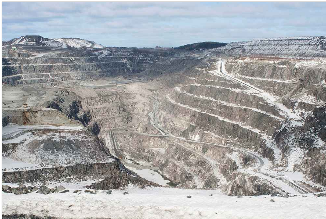
Kuva 3-1. Särkijärven päälouhos etelästä päin katsottaessa maaliskuussa 2016. Takaoikealla Itäläjitys (sivukivialue). Kuva: Toni Uusimäki.
