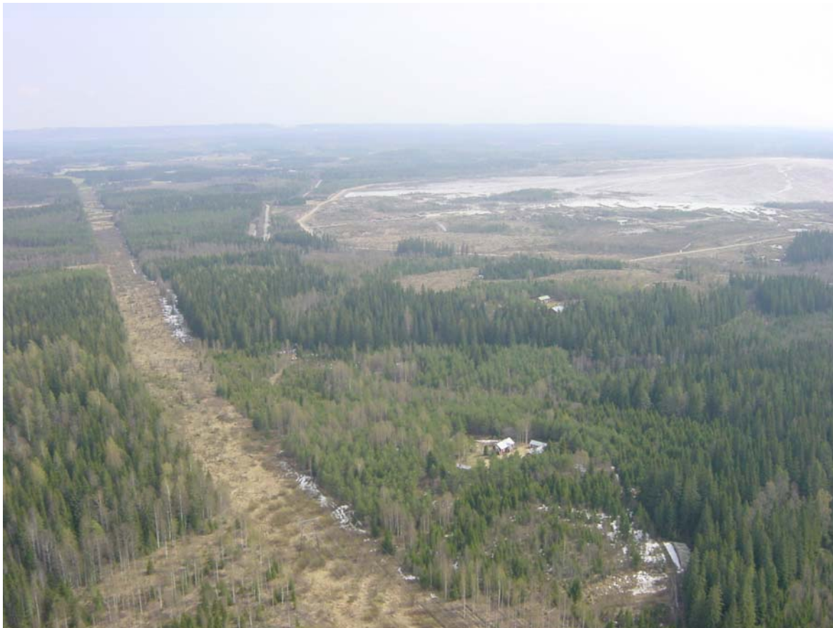
Kuva 9.17. Mustin nykyisen rikastushiekka-altaan täyttämätön pohjoisosa ja pohjoisen allaslaajennuksen aluetta (kuvattu lännestä). 110 kW:n sähkölinja kulkee kuvan vasemmassa laidassa.
