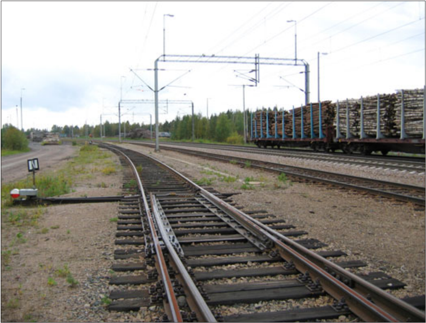
Kuva 32. Ratapihat ja lastauspaikat ovat potentiaalisia pilaantuneen maan riskikohteita. Kuva Kannuksesta.
