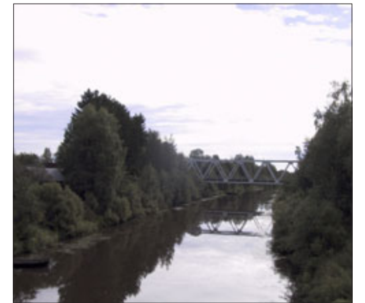
Kuva 48. Temmesjoen silta on maisemallisesti merkittävä rakenne kulttuurihistoriallisessa ympäristössä.
