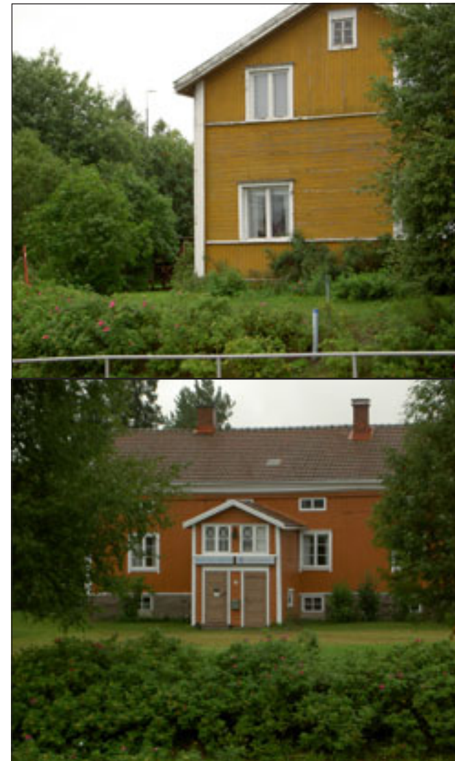
Kuva 42. Ylivieskassa radanvarteen sijoittuvat paikallisesti arvokkaat rakennukset ovat kaupunkikuvallisesti tärkeitä. Palvelutason nosto ei vaikuta niihin haitallisesti.
