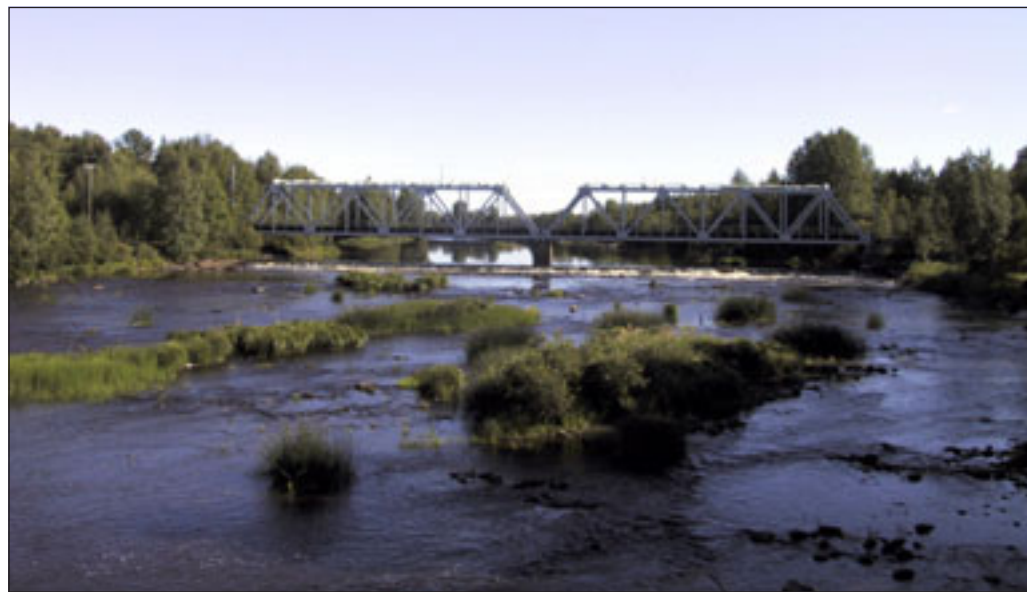
Kuva 47. Ruukin silta on keskeinen rakenne kulttuurihistoriallisesti merkittävässä ympäristössä. Kaksoisraiteen rakentaminen olisi Ruukin maiseman kannalta hyvin vahingollista.
