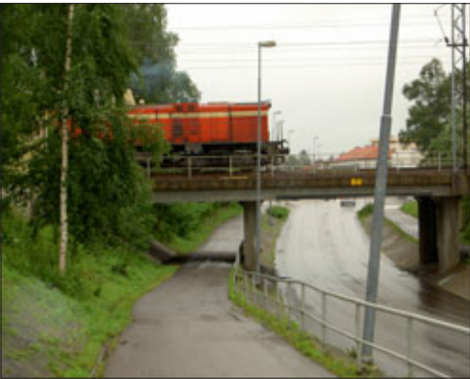
Kuva 62. Ylivieskassa rautatie sijoittuu keskelle kaupunkirakennetta.
