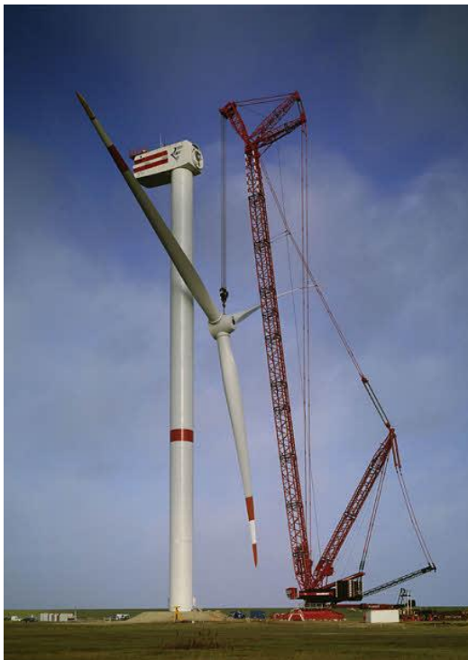
Kuva 12. Tuulivoimalan pystytys tela-alustaisella nosturilla (Liebherr).
