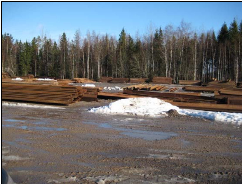
Kuva 3-9. Rakennustarvikkeiden varastointia; lagring av byggförnödenheter
