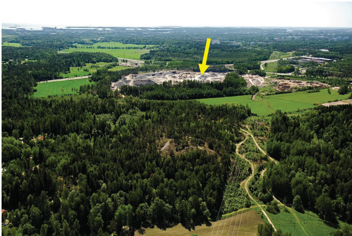
Kuva 7-2. Viistoilmakuva pohjoisesta kohti hankealuetta. Jätevoimalarakennuksen likimääräinen sijainti on osoitettu keltaisella nuolisymbolilla. Kuvassa etualalla Ojangan virkistysaluetta.
