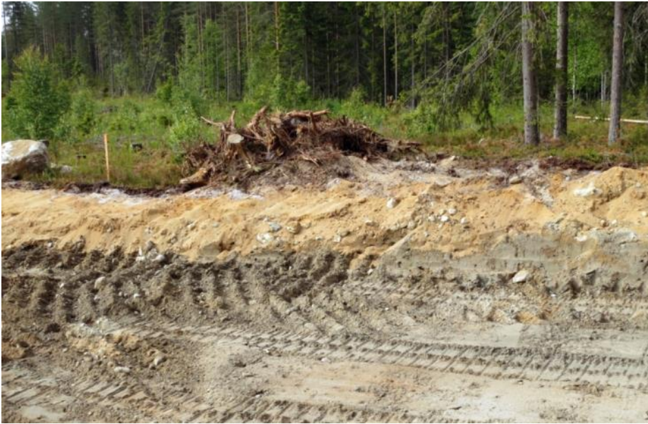
Kuva 10.4. Hankealueen eteläosan lajittunut hiekka-hieta-aines (kuvassa vasemmalla) muuttuu kiviseksi hiekkamoreeniksi ja edelleen sen alla olevaksi harmaaksi hiesu-savikerrokseksi Voimatien uudessa leikkauksessa tasolla 135 m mpy.
