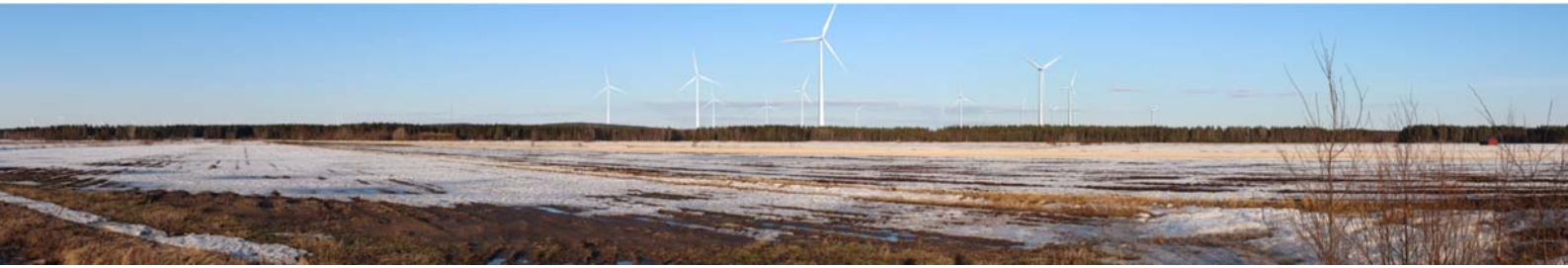
Bild 39. Fotograferingsplats 1, östsidan av Lappfjärds by (Lappfjärdsvägen), ALT 2. I detta alternativ är kraftverken högre än i alternativ ALT 1. De högre kraftverken dominerar i någon mån landskapet ännu mera. Skillnaden mellan alternativen är dock relativt liten. Kraftverken syns i två utsiktssektorer
