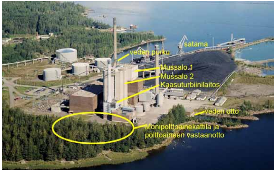
Kuva 2. Mussalon voimalaitosalue. Kuva: Pohjolan Voima Oy.
