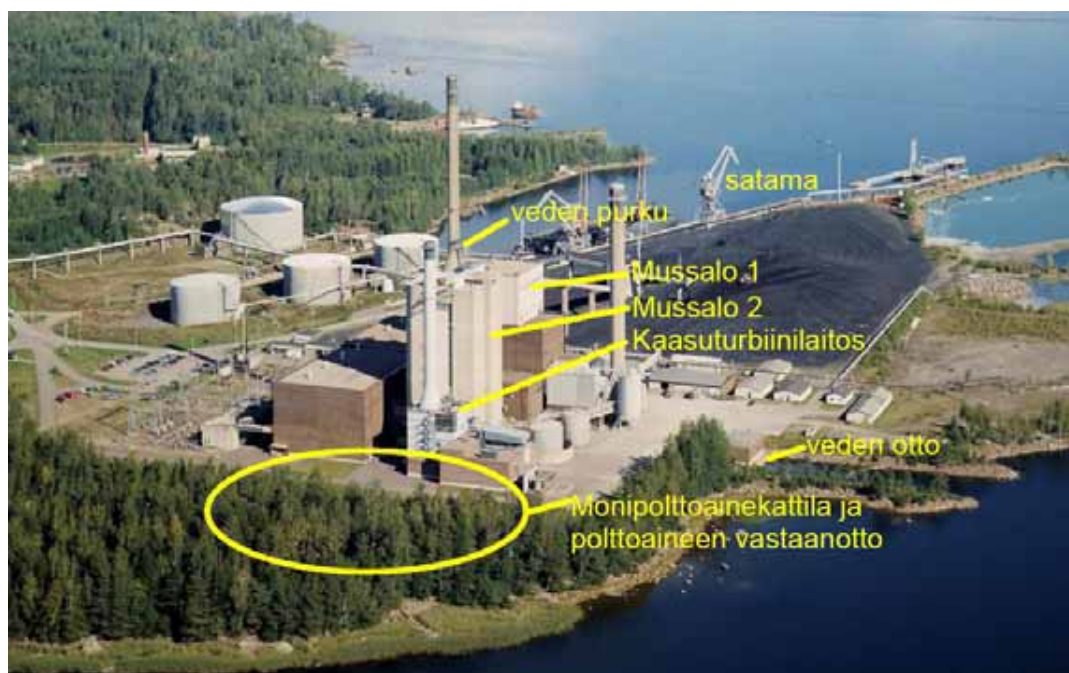
Kuva 1. Mussalon voimalaitosalue ja suunniteltu hankealue (monipolttoainekattila ja polttoaineen vastaanotto).
