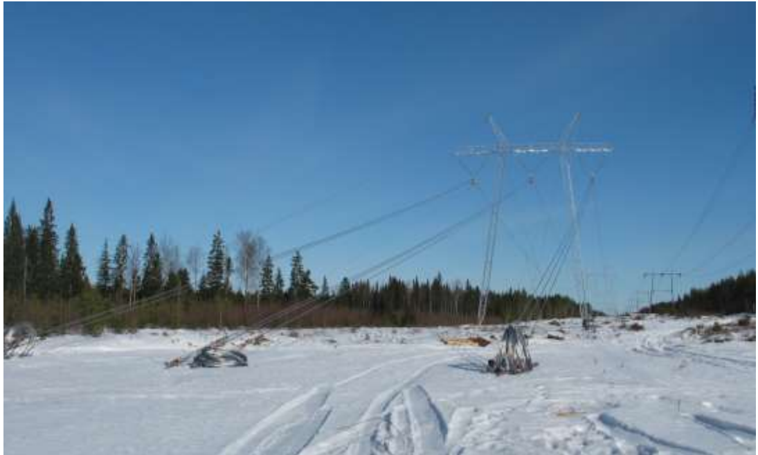
Kuva 1.5. Rakenteilla oleva 400 kV voimajohto (kuva: TLT Engineering Oy).
