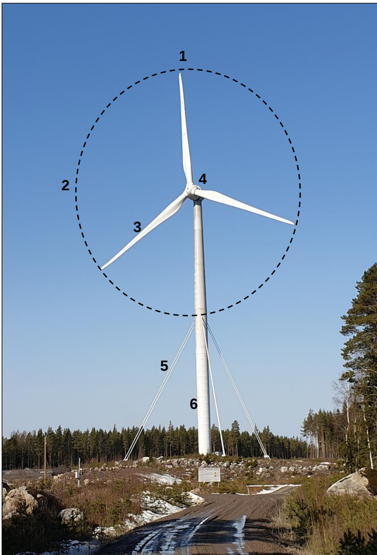
Kuva 5. Tuulivoimalan rakenne ja termit: 1) kokonaiskorkeus 2) roottori, roottorin halkaisija 3) lapa 4) naselli, konehuone, napakorkeus 5) mahdolliset harukset 6) torni
