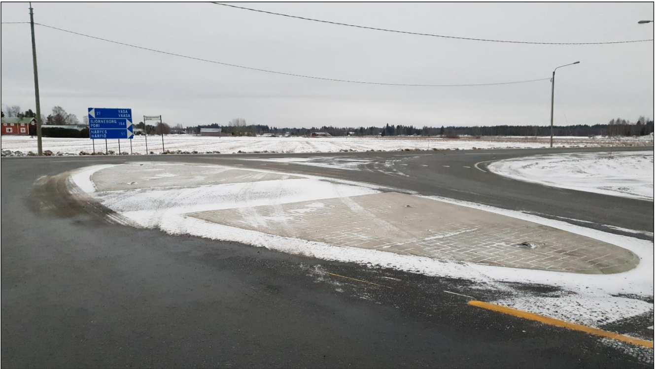
Kuva 7. Kuva Valtatie 8:n ja Maalahdentien risteyksestä. Pitkät kuljetukset vaativat suuren kääntösäteen ja ne voivat ylittää erikoiskuljetuksia silmällä pitäen rakennetun matalan liikenteenjakajan.
