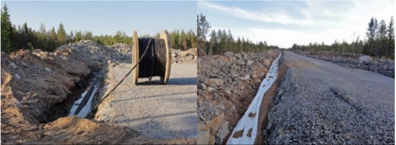
Kuva 5.11. Maakaapelit upotetaan huoltoteiden yhteyteen (Ville Suorsa, FCG).
