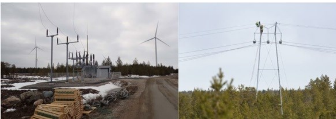
Kuva 5.15. Sähköaseman ja voimajohdon rakentamista (Ville Suorsa, FCG).
