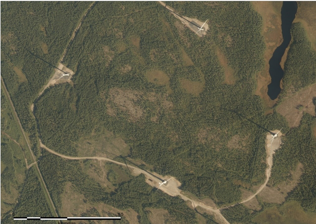
Kuva 5.1. Ilmakuva rakennetusta tuulivoimapuistosta (Maanmittauslaitos). Kuva ei ole Haarasuonkankaan alueelta.
