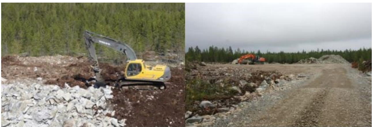
Kuva 5.10. Tuulivoimapuiston rakentaminen alkaa huoltoteiden ja pystytysalueiden rakentamisella (Ville Suorsa, FCG).
