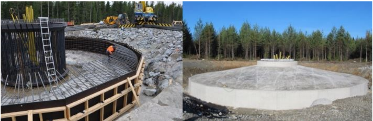
Kuva 5.12. Tuulivoimalan perustusten rakentamista (Leila Väyrynen, FCG).
