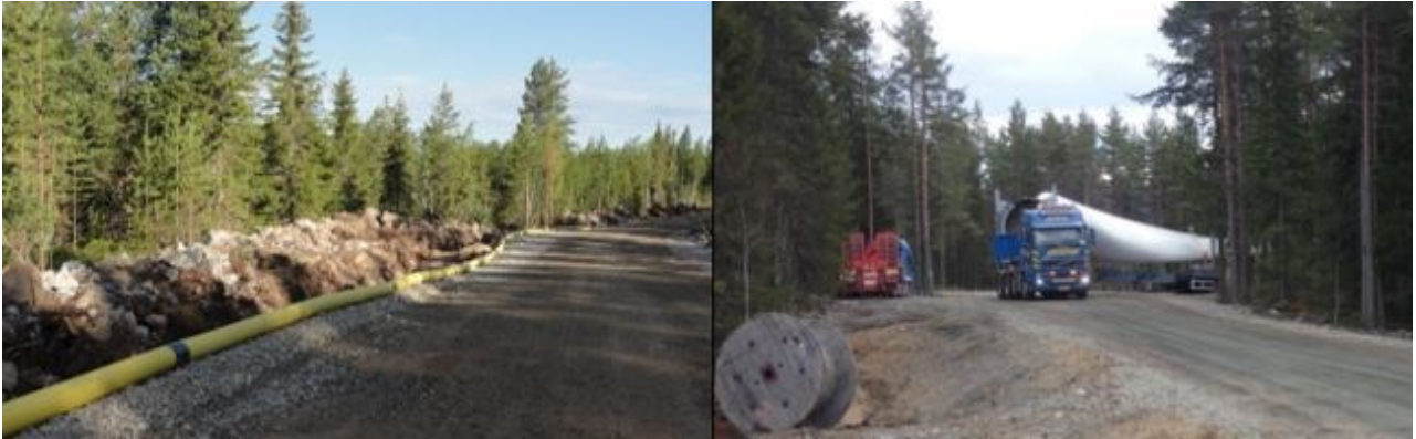
Kuva 5.7. Vasemmalla esimerkki tuulivoimapuiston rakennus- ja huoltotiestä. Oikealla tuulivoimalan osia kuljetetaan erikoiskuljetuksina (Ville Suorsa, FCG).
