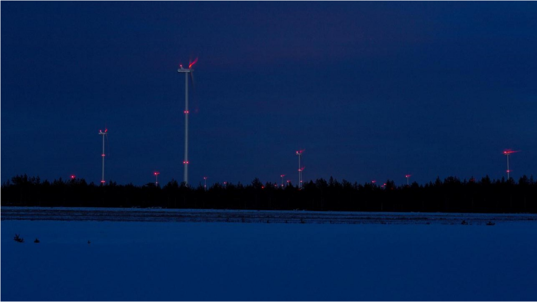
Kuva 5.5. Kiinteät punaiset lentoestevalot (Ville Suorsa, FCG).
