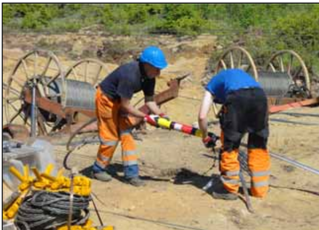
Kuva 162. Voimajohtojen johdinten liittämisen yhteydessä käytetään räjäytettäviä liitoksia.
