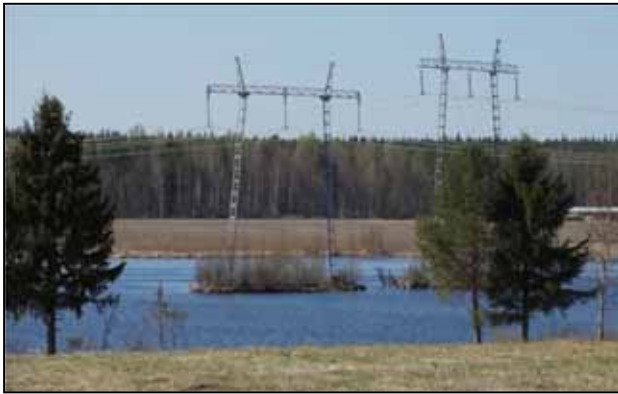
Kuva 22. Tekoluodolle rakennettu nykyinen voimajohtopylväs Haapajärven Kortejärvellä.
