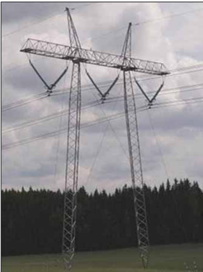
Kuva 20. Harustettu 400 kilovoltin portaalipylväs.
