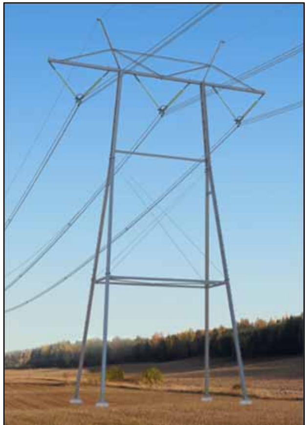
Kuva 21. Harustamaton 400 kilovoltin portaali-peltopylväs (havainnekuva).
