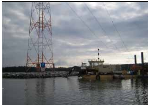
Kuva 24. Vapaasti seisovan pylvään tekoluodon reunaluiskien viimeistelyä (Pyhäjärvi, Pirkkala).
