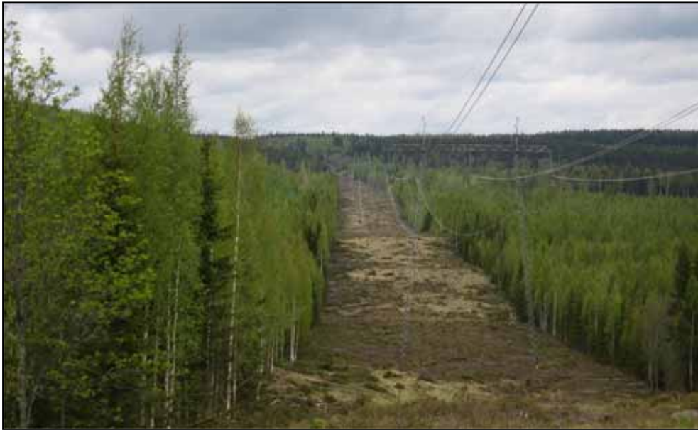
Kuva 42. Voimajohdolle raivataan puuttomana pidettävä johtoaukea.
