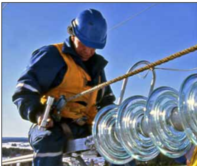
Kuva 163. Voimajohtopylvään eristimiä, joissa koronapurkauksia voi esiintyä.
