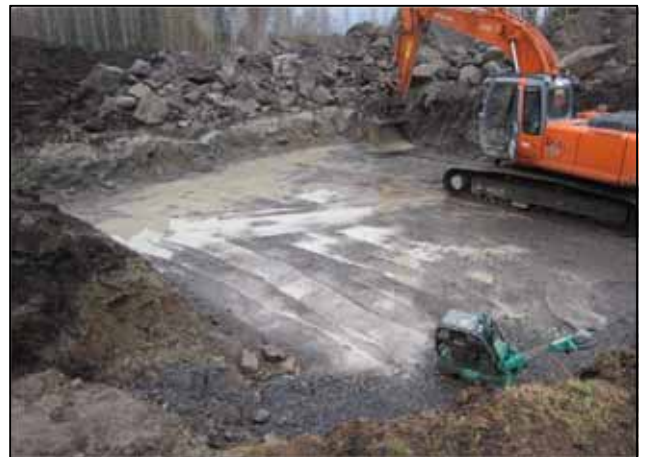
Kuva 10. Vapaasti seisovan pylvään perustuksen pohjatöitä.
