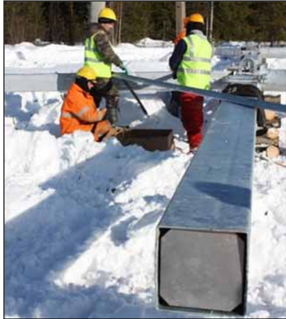
Kuva 12. Voimajohtopylvään kokoamista pylväs paikalla.
