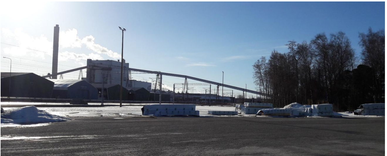
Kuva 7-3. Näkymä Alholmanin Sahan portista kohti etelää. Kuvassa Alholmens Kraftin hihnakuljetin sekä rautatie. Kuvan ottopaikka ja -suunta on merkitty kuvassa 7-2 punaisella nuolella. (kuva: Elin Siggberg)
