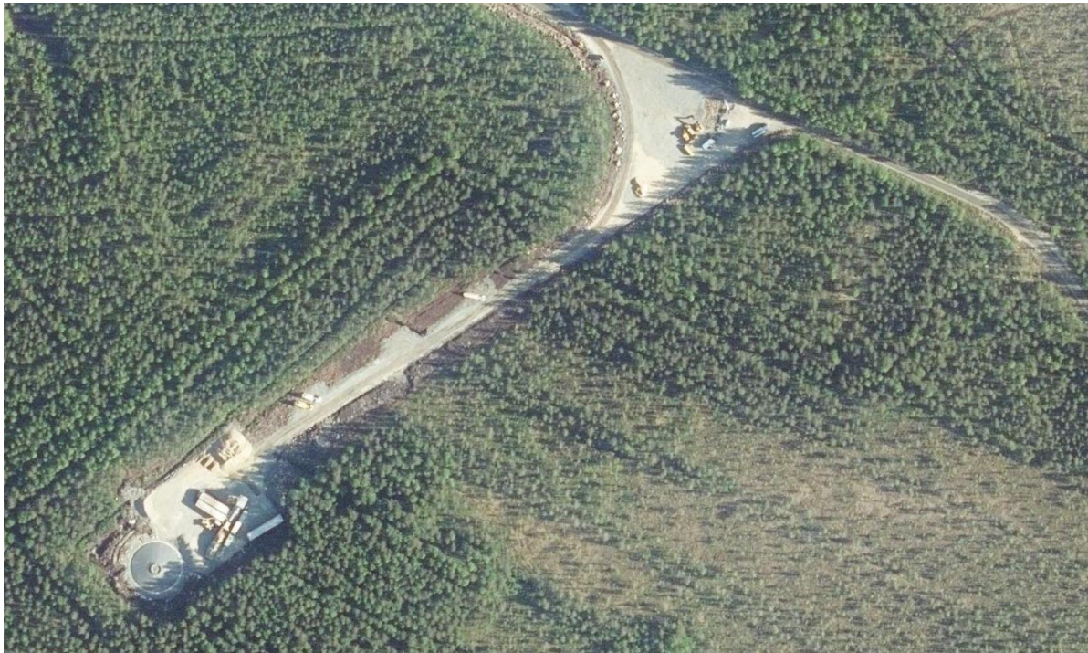
Kuva 16. Esimerkki tuulivoimalan rakennustyömaasta. (Ilmakuvan lähde: Maanmittauslaitos, avoimet aineistot 2022).
