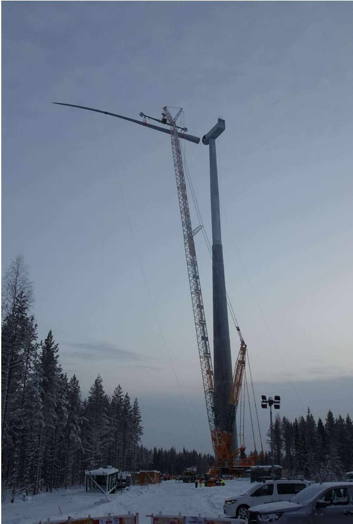
Kuva 21. Voimalan siiven asennus käynnissä. Asennus on mahdollista myös talviaikaan. (Kuva J. Silvola, Ramboll)
