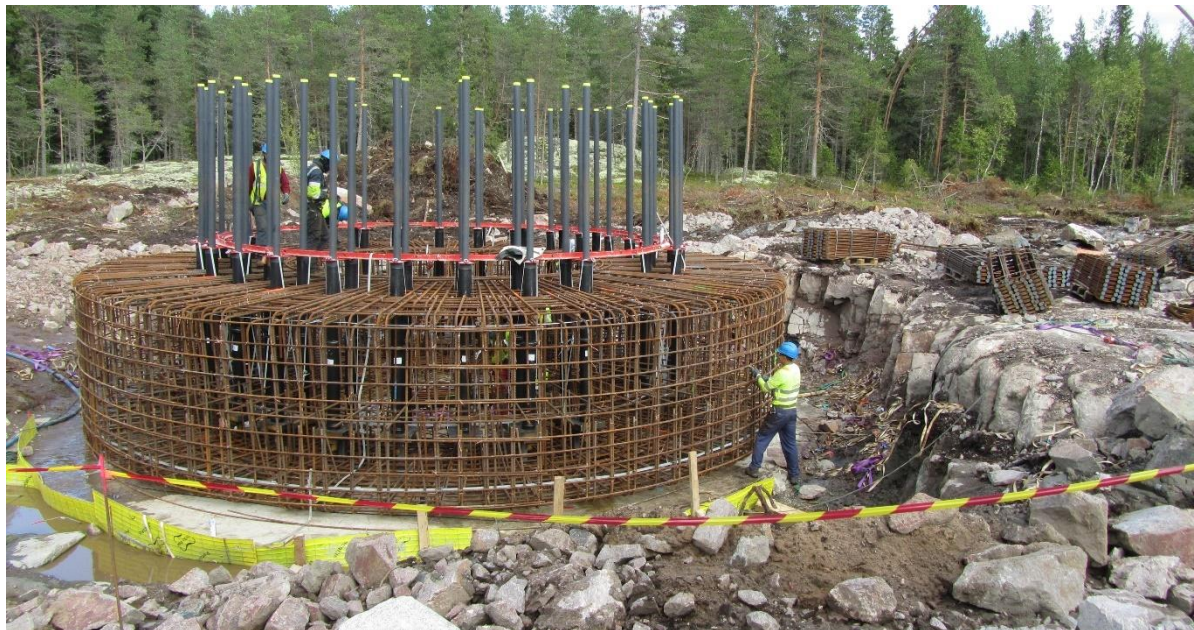
Kuva 12. Kallioankkuroidun teräsbetoniperustuksen raudoitusten valmistelua. (Kuva J. Silvola, Ramboll)
