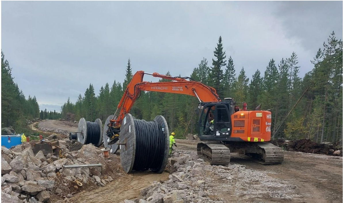
Kuva 8. Maakaapeliä asennustyö käynnissä. (Kuva J. Silvola, Ramboll)
