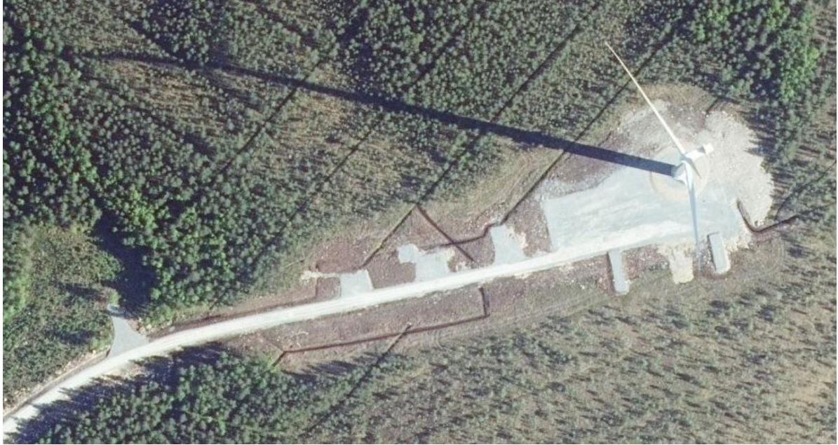
Kuva 17. Esimerkki juuri valmistuneen tuulivoimalan asennusalueesta. (Ilmakuvan lähde: Maanmittauslaitos, avoimet aineistot 2022).
