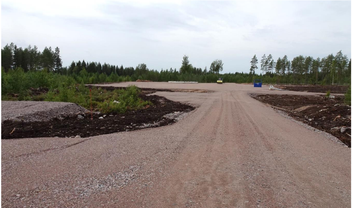
Kuva 15. Voimalan nostokentän rakennustyömaa. (Kuva J. Silvola, Ramboll)
