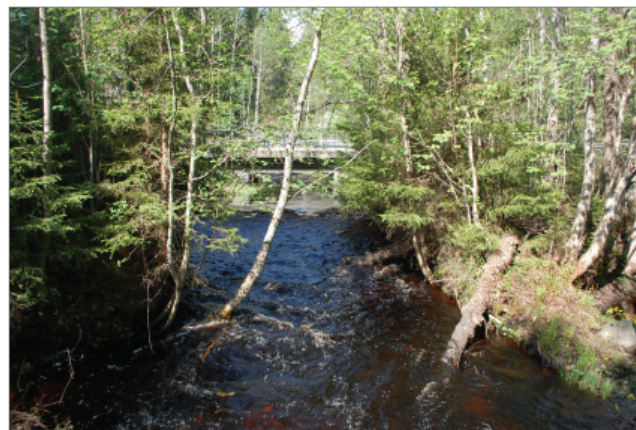
Kuva 52. Valtatie 5 ylittää Myllyjoen Vehmaan eritasoliittymän tuntumassa.
