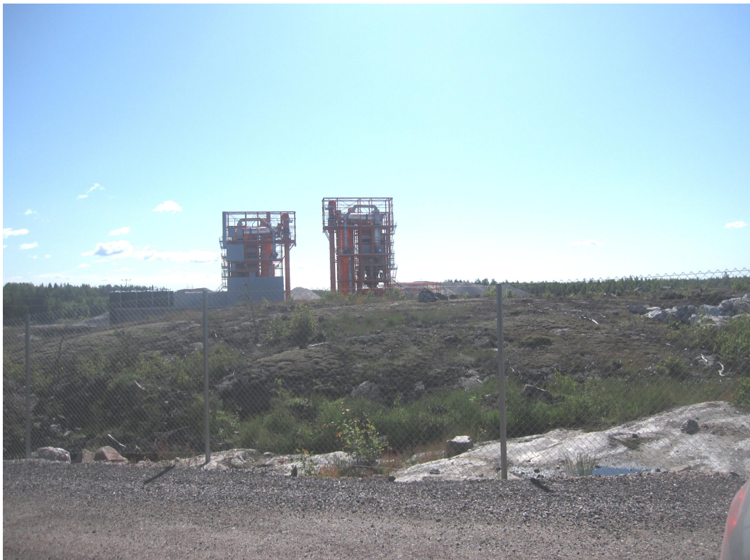
Kuva 7-6. Näkymä lännestä kohti hankealuetta. Kuvassa näkyy hankealueella vielä olevaa louhittavaa kallioaluetta.
