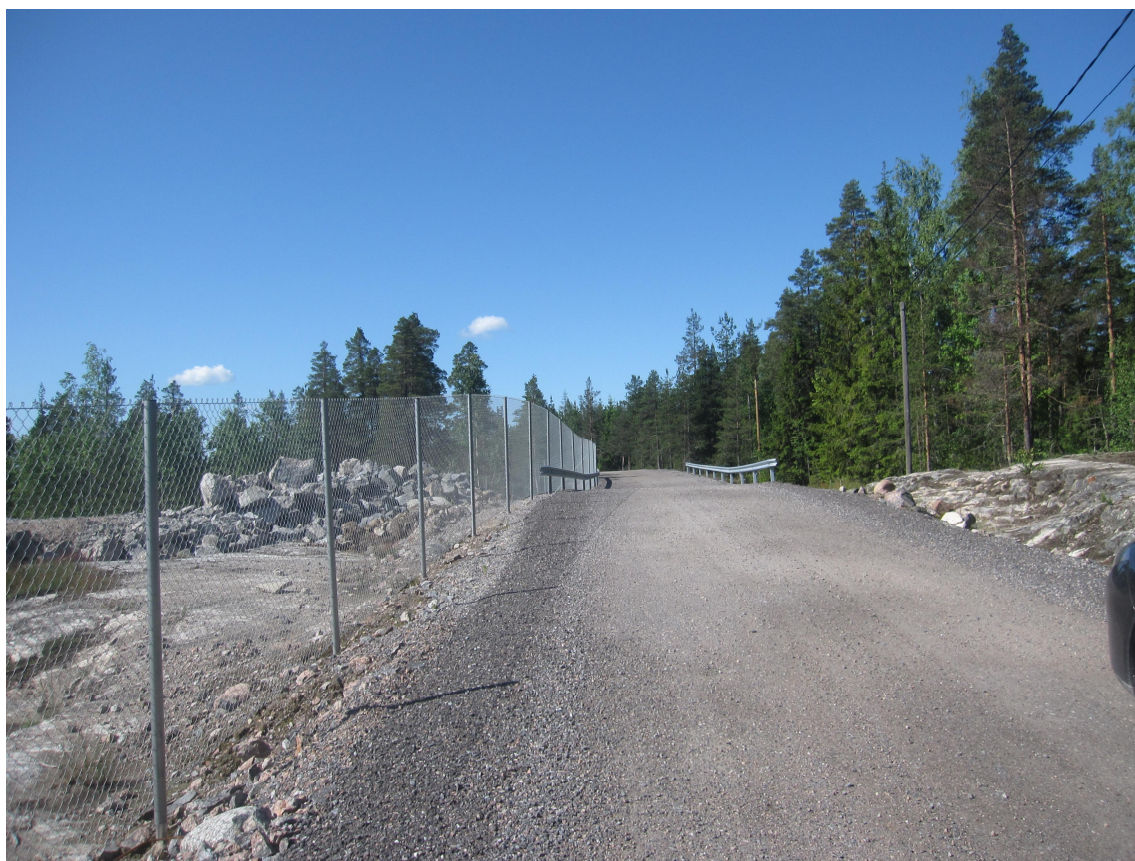
Kuva 7-13 a. ja b. Näkymiä hankealueen länsirajalla kulkevaa Ruohosuontietä pitkin kohti etelää. Osa hankealueelta vielä louhittavasta kallioalueesta näkyy kuvassa vasemmalla.
