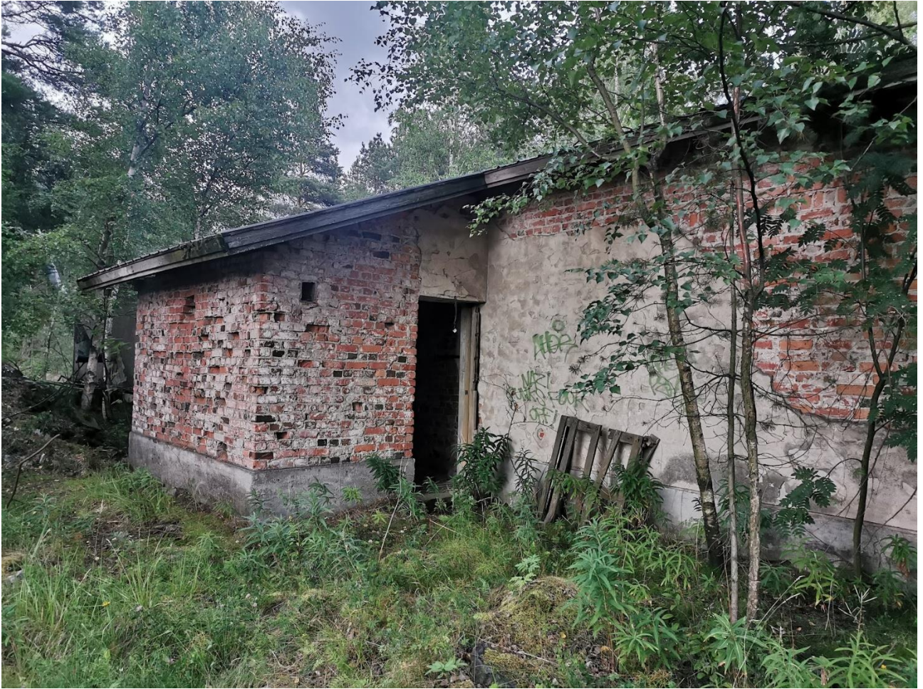
Kuva 3. Alueella sijaitseva vanha rakennus.
