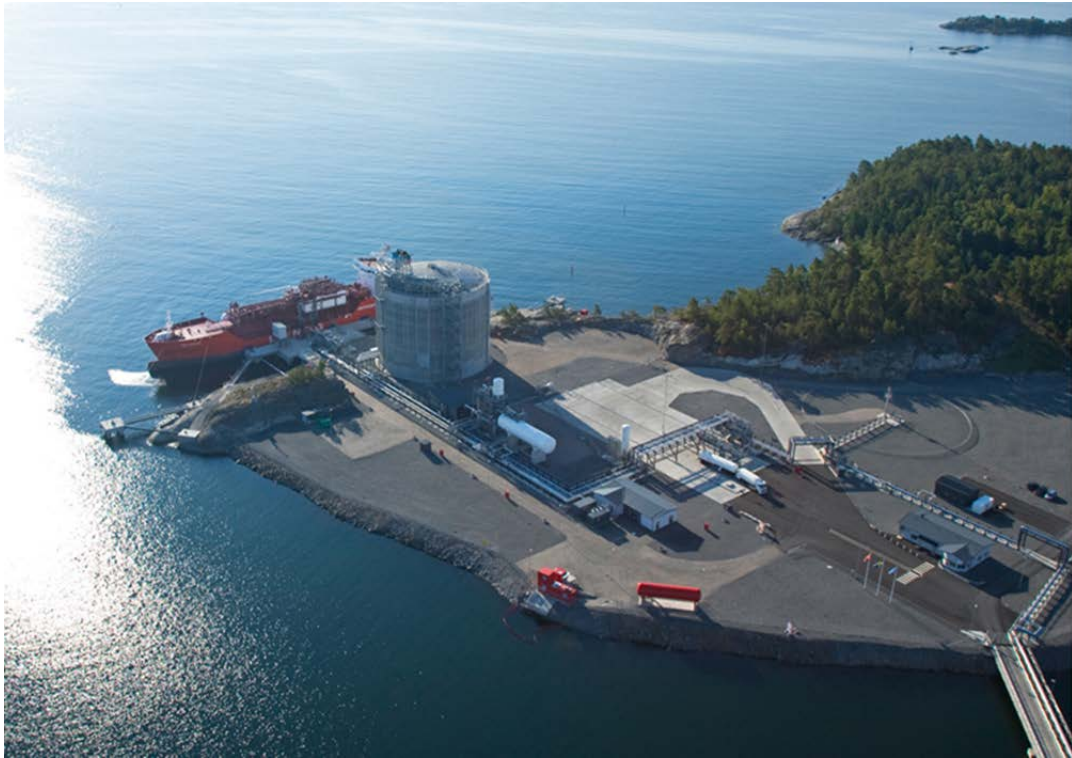
Kuva 5. Esimerkki LNG-terminaalista. AGA:n uusi terminaali Ruotsin Nynähamnissa, jossa säiliökapasiteetti on 20 000 m 3 .
