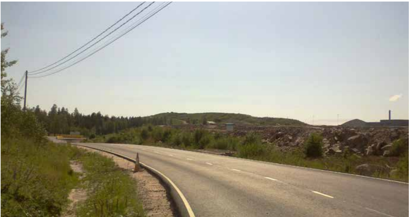
Kuva 10. Näkymä Kulmakorventieltä kohti Kalliosuon maankaatopaikan pohjoista laajennusosaa.
