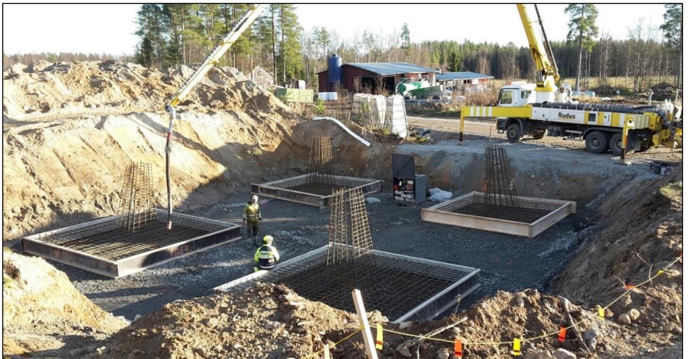
Kuva 3.5. Vapaasti seisovan pylvään perustuksen pohjatöitä.
