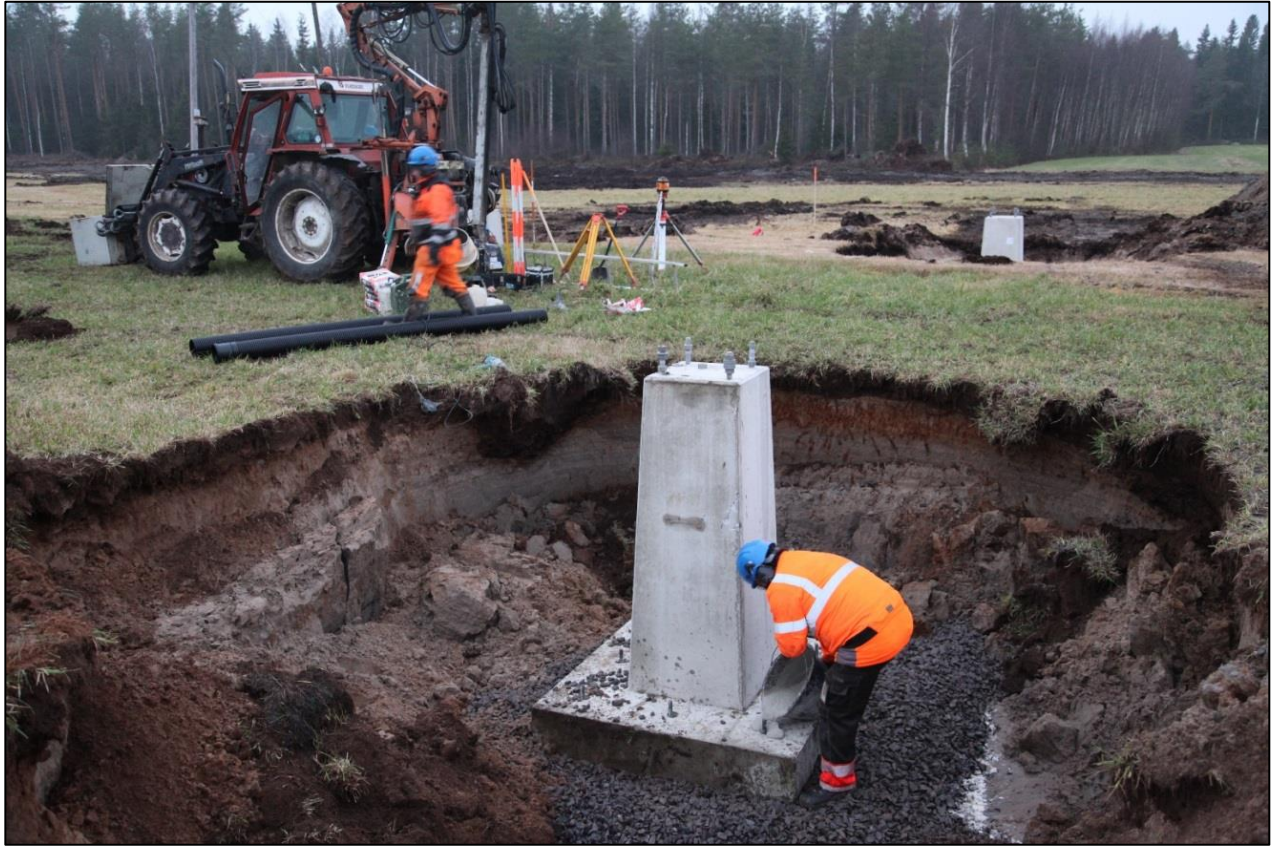
Kuva 3.4. Pylvään perustuselementin asentaminen.
