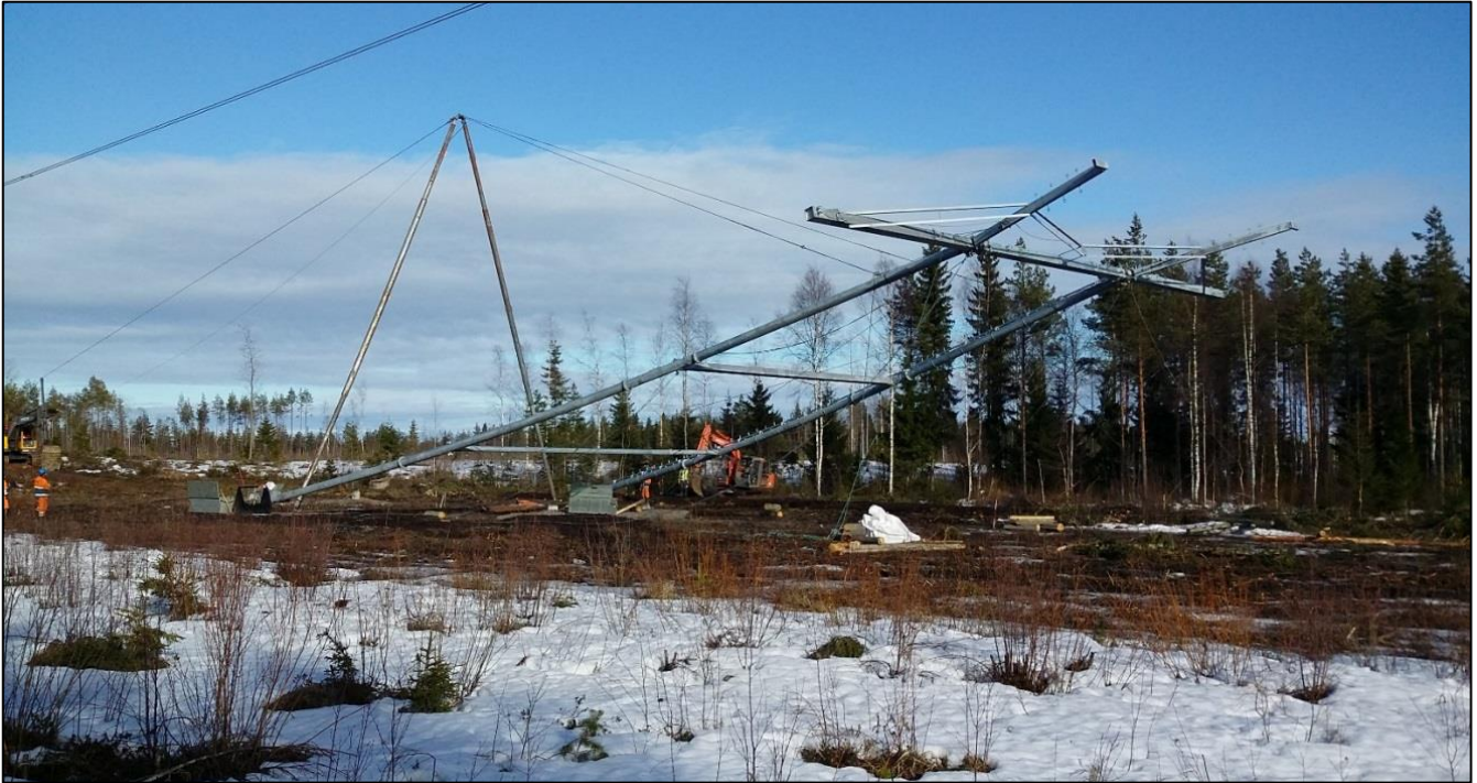
Kuva 3.6. Voimajohtopylvään pystytys.
