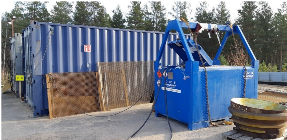
Kuva 2-7. Tukitoiminta-alueella sijaitsevat vaarallisten aineiden kontit ja polttoainesäiliö.
