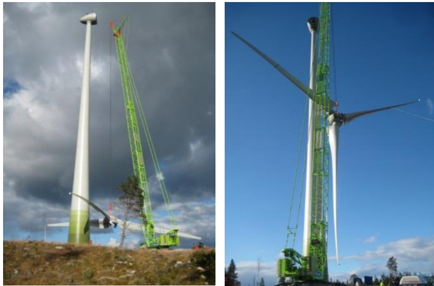
Kuva 15: Roottorin asennus. © Triventus Consulting AB
