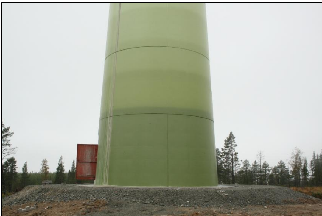
Kuva 8: Maavarainen teräsbetoniperustus. © Triventus Consulting AB
