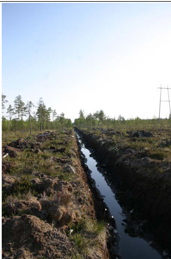
Kuva 4. Pohjoisosassa on tehty tuoreita ojituksia.
