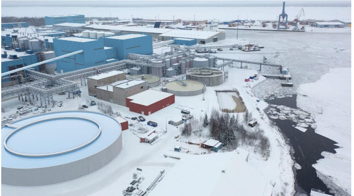
Kuva 7-5. Ylemmässä kuvassa on nykytilaa kuvaava valokuva ja alemmassa kuvassa on havainnollistettu uutta jätevedenkäsittely-yksikköä (VE1).
