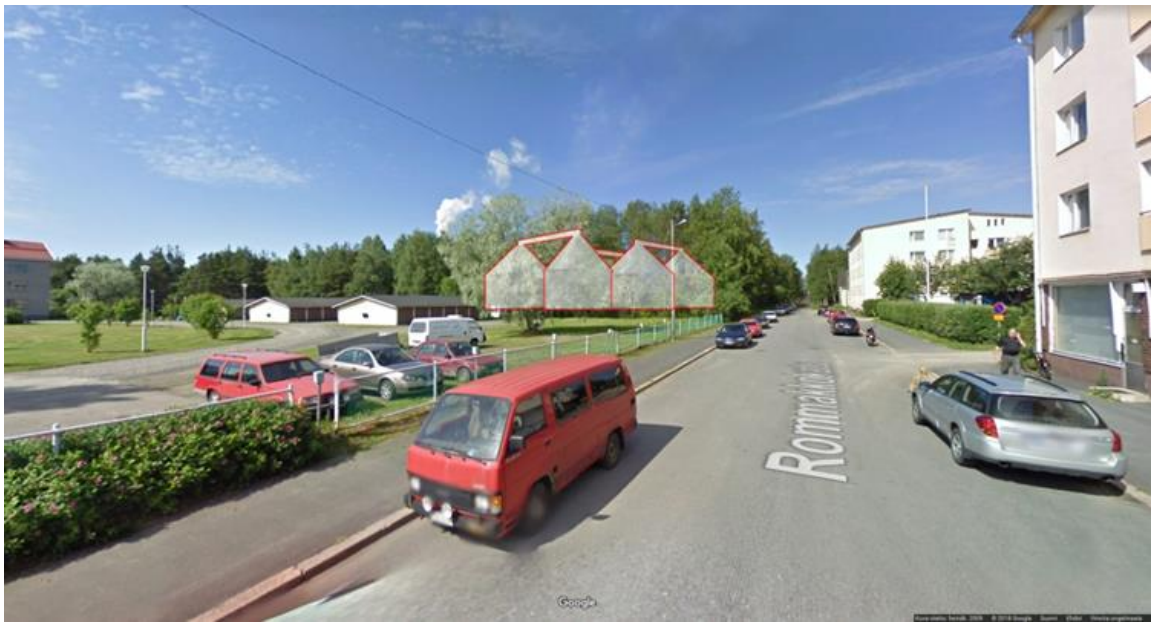
Kuva 7-16. Kuvassovite uusista hakesiiloista (kolme on jo rakennettu) maan tasosta puunkäsittelyalueen etelä-puolelta Rommakkokadulta (ylempi kuva). Koska puusto peittää siilot, on alemmassa kuvassa esitetty siilojen ääriviivat. (Havainnekuva: UKI Arkkitehdit Oy)
