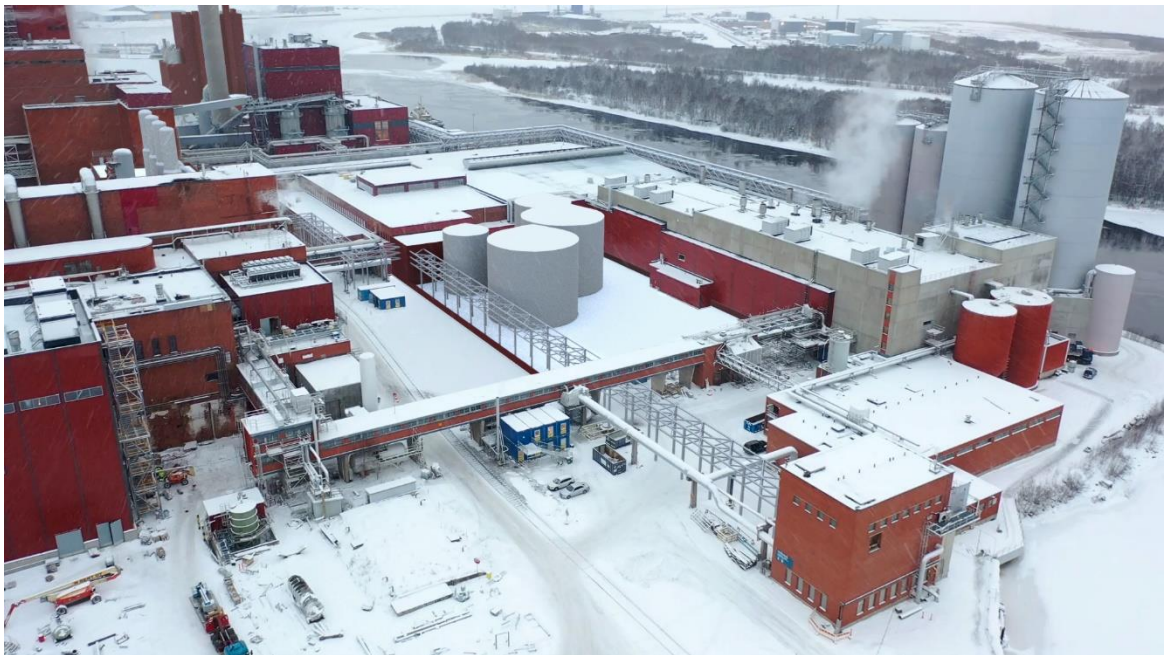
Kuva 7-8. Ylemmässä kuvassa on nykytilaa kuvaava valokuva ja alemmassa kuvassa on havainnollistettu uusi hajukaasukattila (VE1).
