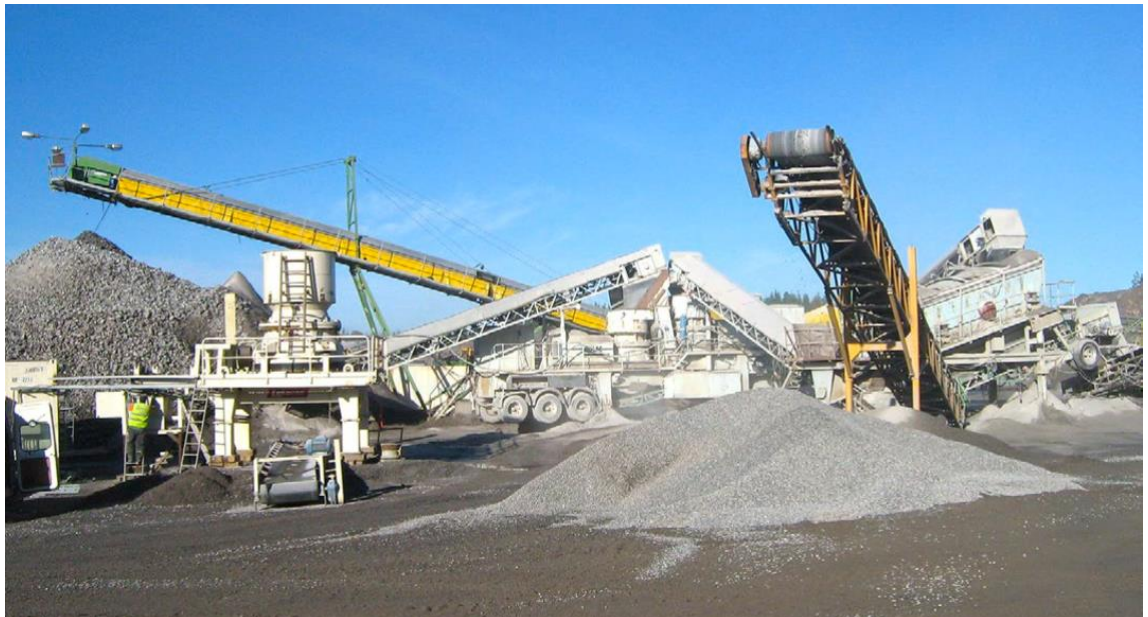
Kuva 3-6. Esimerkki kivenmurskaamosta. Kuva ©: Ympäristöministeriö 2020 / Jari Rintala.
