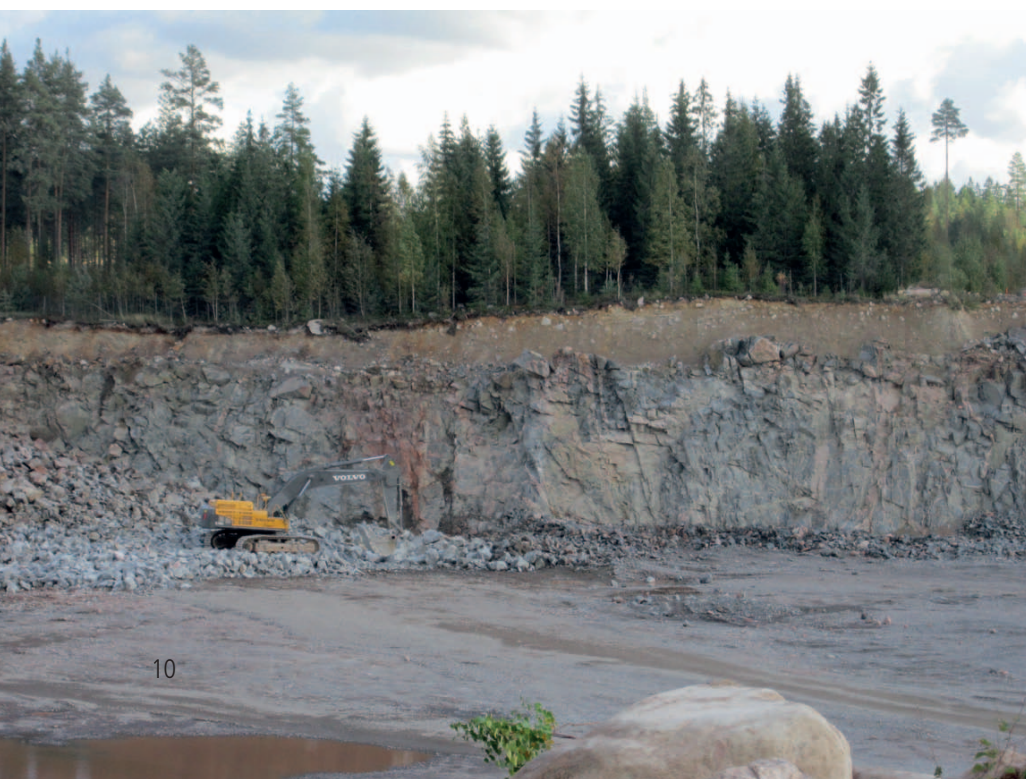
■ Kuva 4.5. Kuvassa louhittava rinta, josta rikotettu louhe kuljete-taan murskattavaksi
