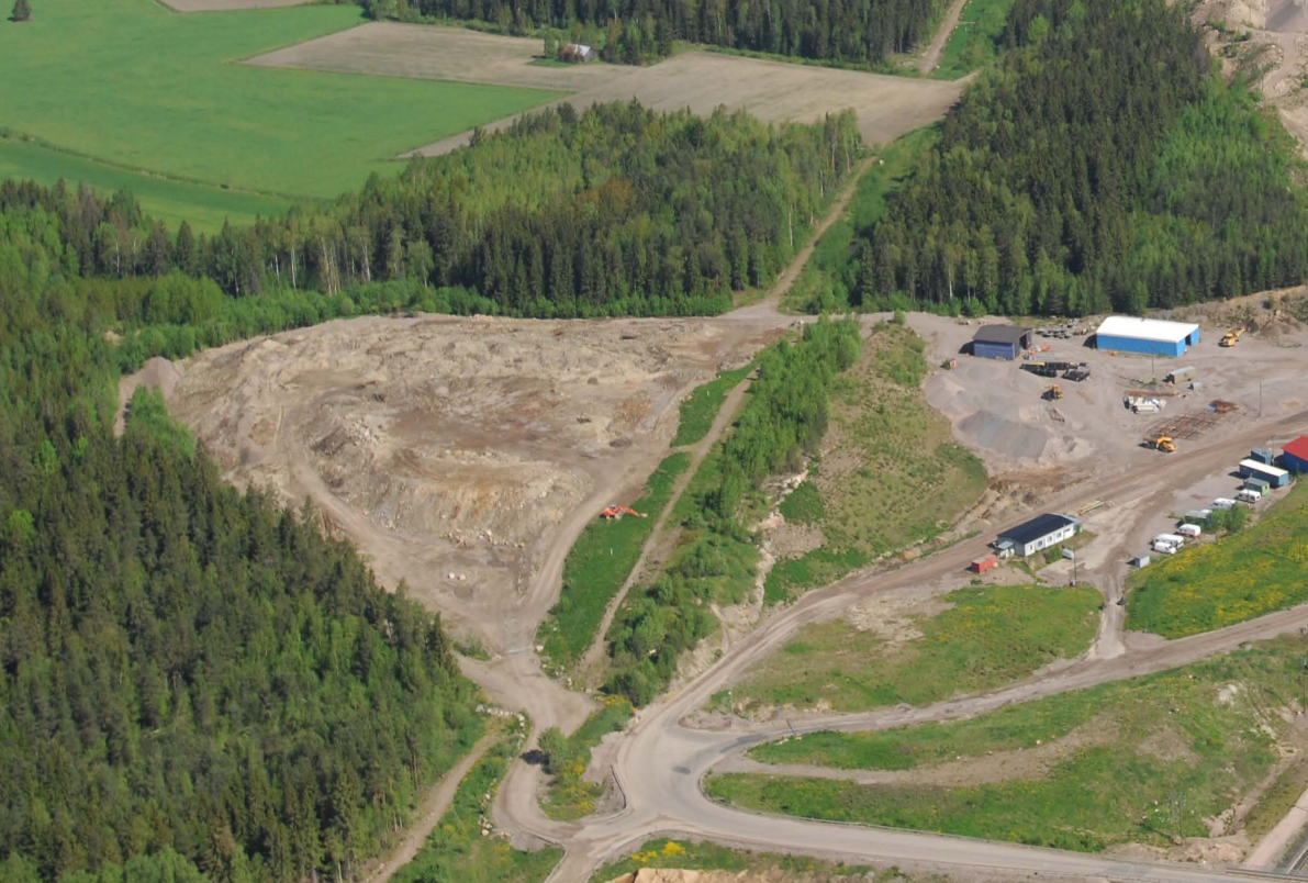
■ Kuva 4.9. Esimerkki maankaatopaikasta täyttövaiheessa. Maankaatopaikkatoiminnan loputtua alueelle muodostuu kasvillisuutta.
