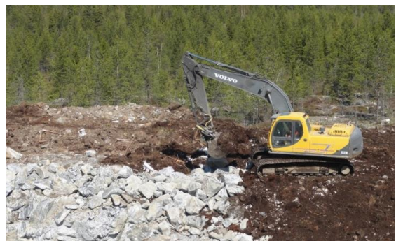
Kuvapari 2.13. Tuulivoimapuiston rakentaminen alkaa huoltoteiden ja pystytysalueiden rakentamisella (kuvat: Ville Suorsa, FCG).
