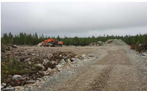
Kuvapari 2.13. Tuulivoimapuiston rakentaminen alkaa huoltoteiden ja pystytysalueiden rakentamisella (kuvat: Ville Suorsa, FCG).
