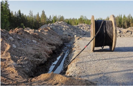
Kuvapari 2.14. Maakaapelit upotetaan huoltoteiden yhteyteen (kuvat: Ville Suorsa/FCG).
