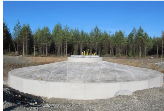
Kuvapari 2.15. Tuulivoimalan perustusten rakentamista. (Kuvat: Leila Väyrynen, FCG)
