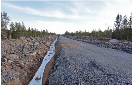
Kuvapari 2.14. Maakaapelit upotetaan huoltoteiden yhteyteen (kuvat: Ville Suorsa/FCG).
