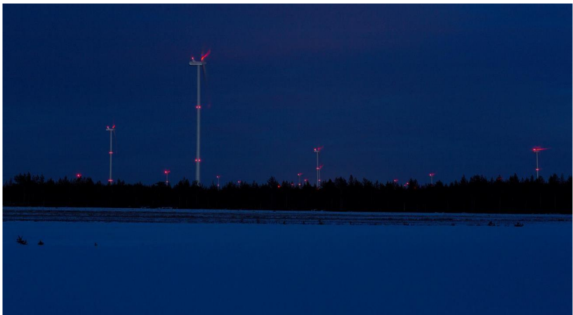
Kuva 2.10. Kiinteät punaiset lentoestevalot. (Kuva: Ville Suorsa, FCG)
