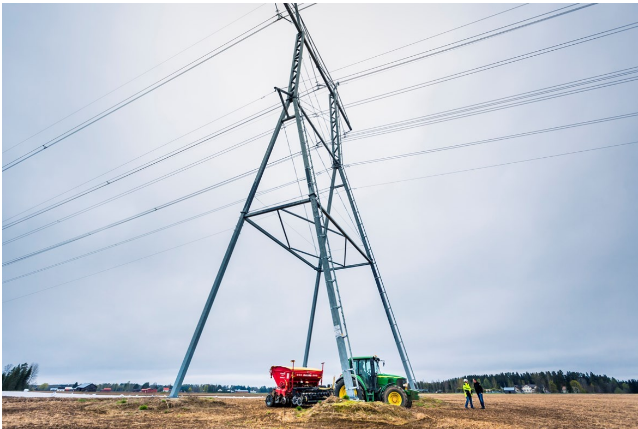
Kuva 204. Esimerkki pelloilla käytettävästä voimajohtopylvästä, jonka suunnittelussa on pyritty minimoimaan maanviljelylle aiheutuvat haitat ja parantamaan työturvallisuutta. Kuvan lähde Fingrid: https://www.fingrid.fi/kantaverkko/kunnossapito/voimajohdot/peltopylvas/ .
