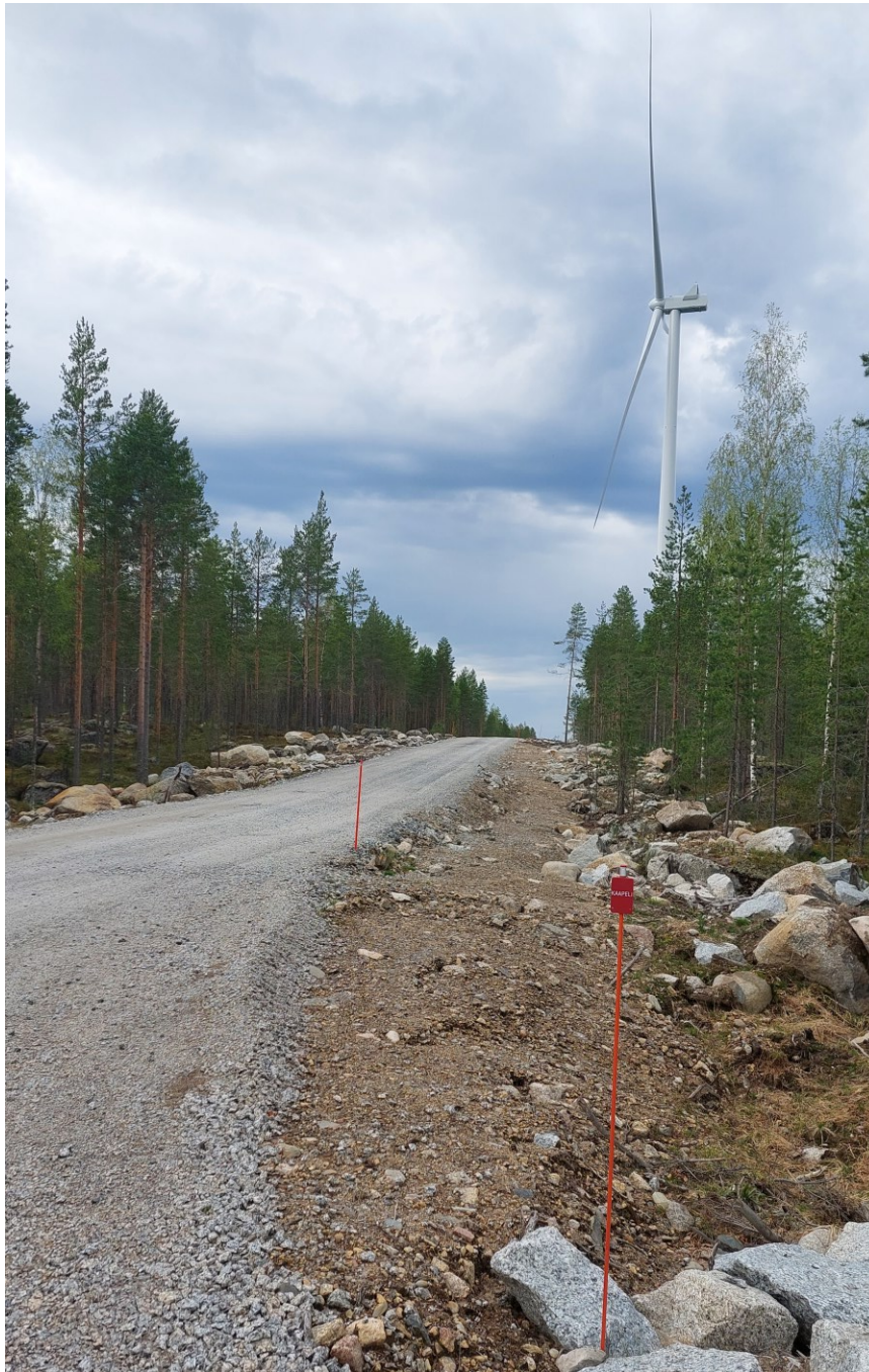
Kuva 17. Esimerkki tuulivoimapuiston rakennus- ja huoltotiestä. Maakaapelin oja on sijoitettu tien oikealle puolelle ja merkitty maastoon viitoin (Ilosjoen tuulipuisto, Pihtipudas). Teitä käytetään muun muassa betonin ja soran sekä voimaloiden komponenttien kuljetuksiin. Tuulivoimapuiston käyttövaiheessa teitä käytetään mm. vuosittaisissa huolloissa.
