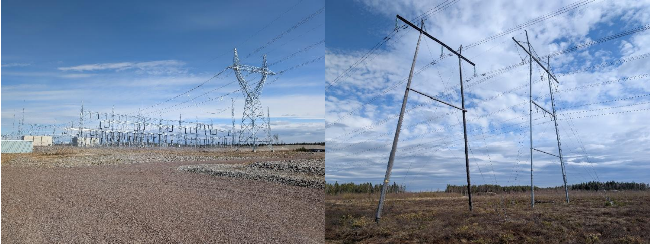
Kuva 8-3. Hankealueen itäpuolella sijaitsee Findgrin Valkeuden sähköasema, johon johtaa hankealueen kaakkoisreunalla kulkevat isot voimajohdot. Kuvat: Mikko Vuorela, Anthesis.
