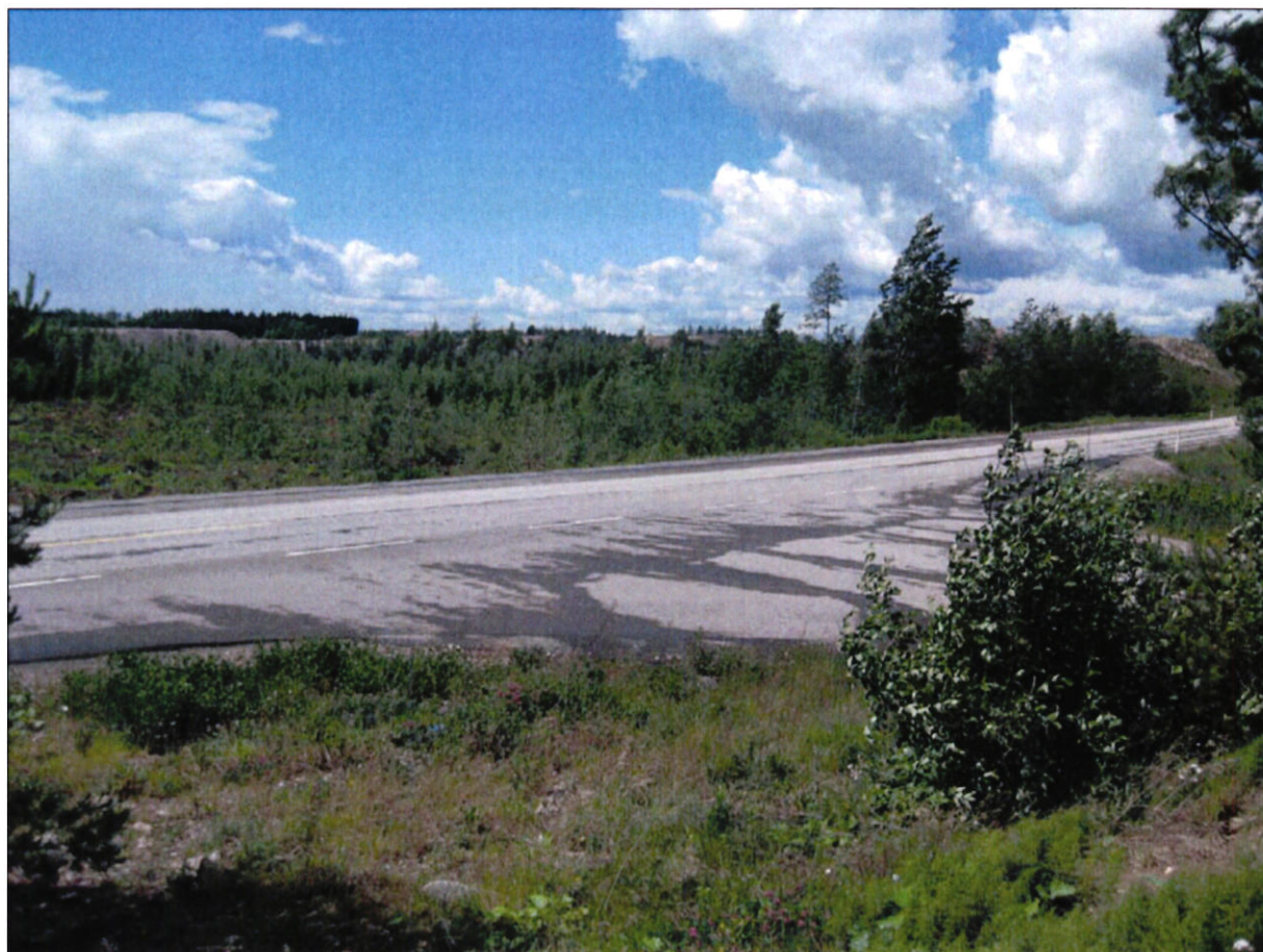
Kuva 8-12. Näkymä Keravantieltä (148) louhinta-alueelle. Edessä näkyvät pohjoisreunan meluvallit.
