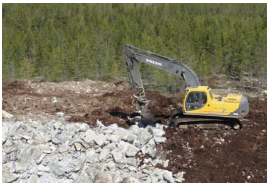
Kuvapari 4.10. Tuulivoimapuiston rakentaminen alkaa huoltoteiden ja pystytysalueiden rakentamisella (Kuvat: FCG).
