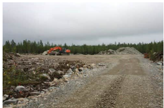
Kuvapari 4.10. Tuulivoimapuiston rakentaminen alkaa huoltoteiden ja pystytysalueiden rakentamisella (Kuvat: FCG).
