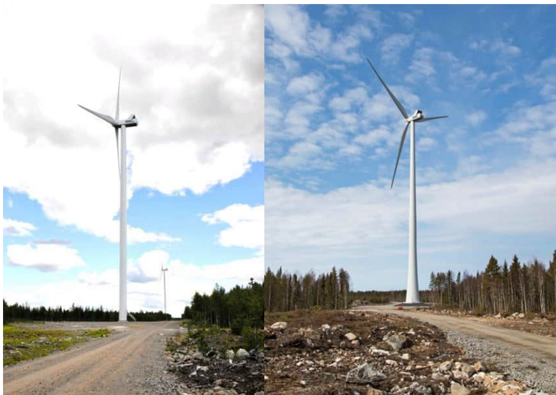
Kuva 4.2. Vasemmalla on esimerkki teräslieriötornista ja oikealla hybriditornista. (Kuvat: Leila Väyrynen, FCG)
