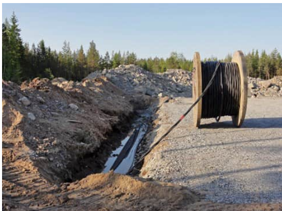
Kuvapari 4.11. Maakaapelit upotetaan pääsääntöisesti huoltoteiden yhteyteen (Kuvat: FCG).
