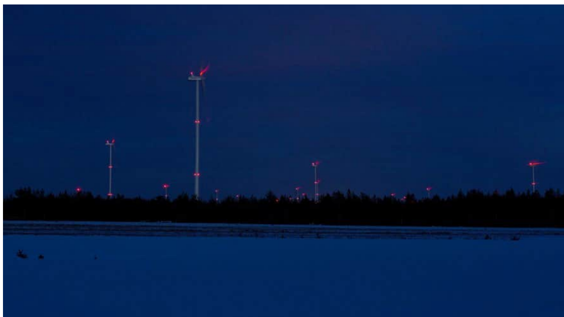
Kuva 4.4. Kiinteät punaiset lentoestevalot. (Kuva: FCG)
