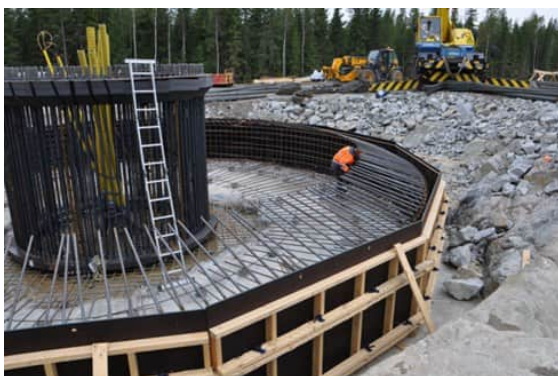
Kuvapari 4.12. Tuulivoimalan perustusten rakentamista (Kuvat: Leila Väyrynen, FCG).
