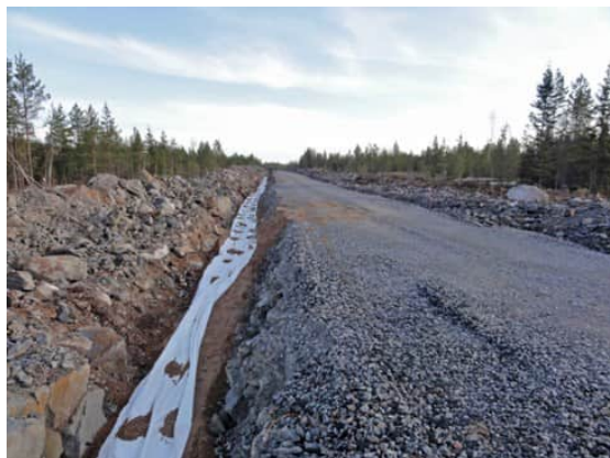
Kuvapari 4.11. Maakaapelit upotetaan pääsääntöisesti huoltoteiden yhteyteen (Kuvat: FCG).
