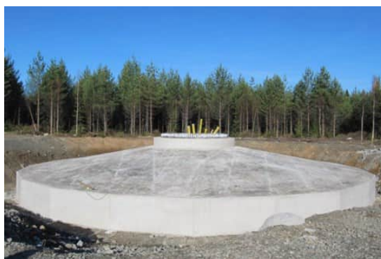
Kuvapari 4.12. Tuulivoimalan perustusten rakentamista (Kuvat: Leila Väyrynen, FCG).
