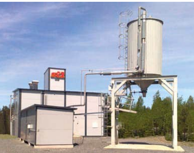
Kuva 5-12 Esimerkkikuva bioetanolilaitoksesta (kuva www.st1.fi )
