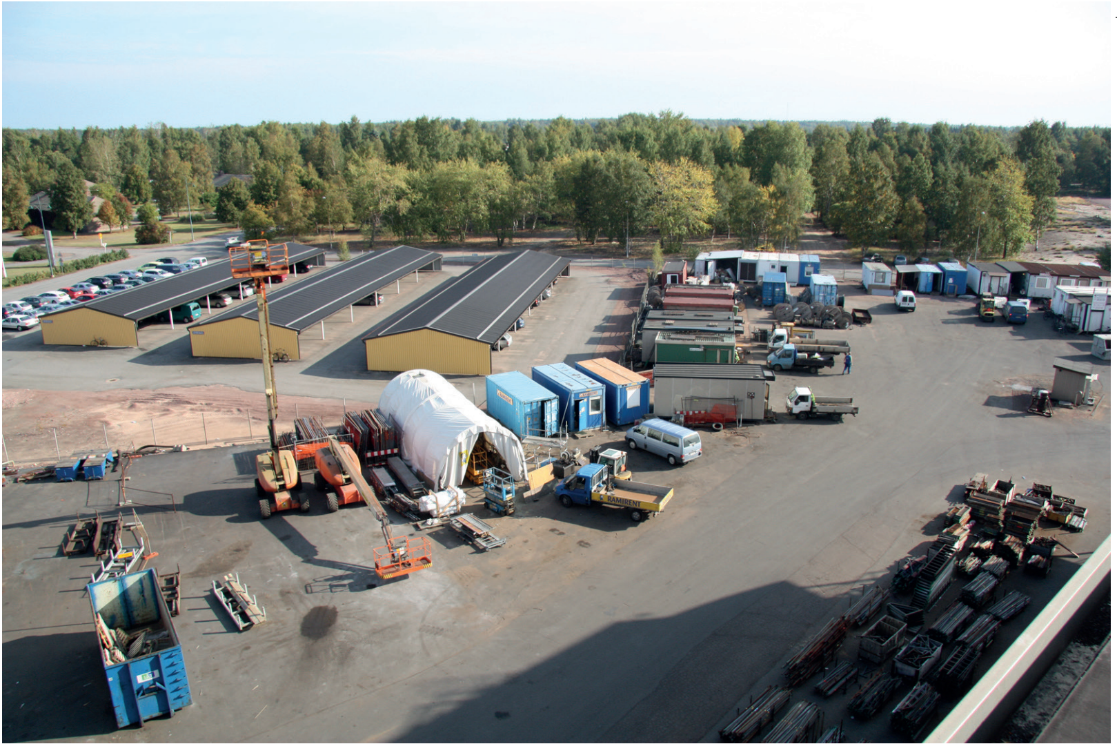
Kuva 28. Rikkihappotehtaan sijaintipaikan ympäristöä (kuva vuodelta 2013).
