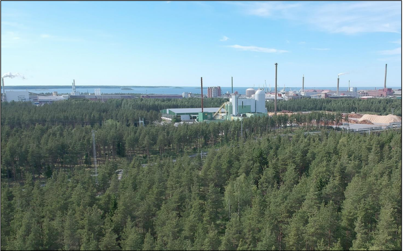
Kuva 4. Hankealue kuvattuna idästä, Hopeakivenlahdentielle. Suunniteltu hanke sijoittuu kuvassa näkyvän Kokkolan Energian voimalaitoksen etelä- ja länsipuolelle. Kuva: Toni Uusimäki / Envineer Oy
