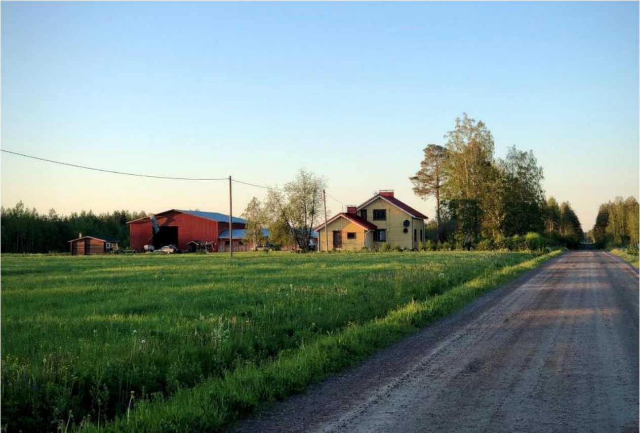
Kuva 30. Valtakunnallisesti arvokasta Miilurannan asutusmaisemaa, Kärämäki (kuva: Tapio Heikkilä, VAMA 2021 Pohjois-Pohjanmaa)
