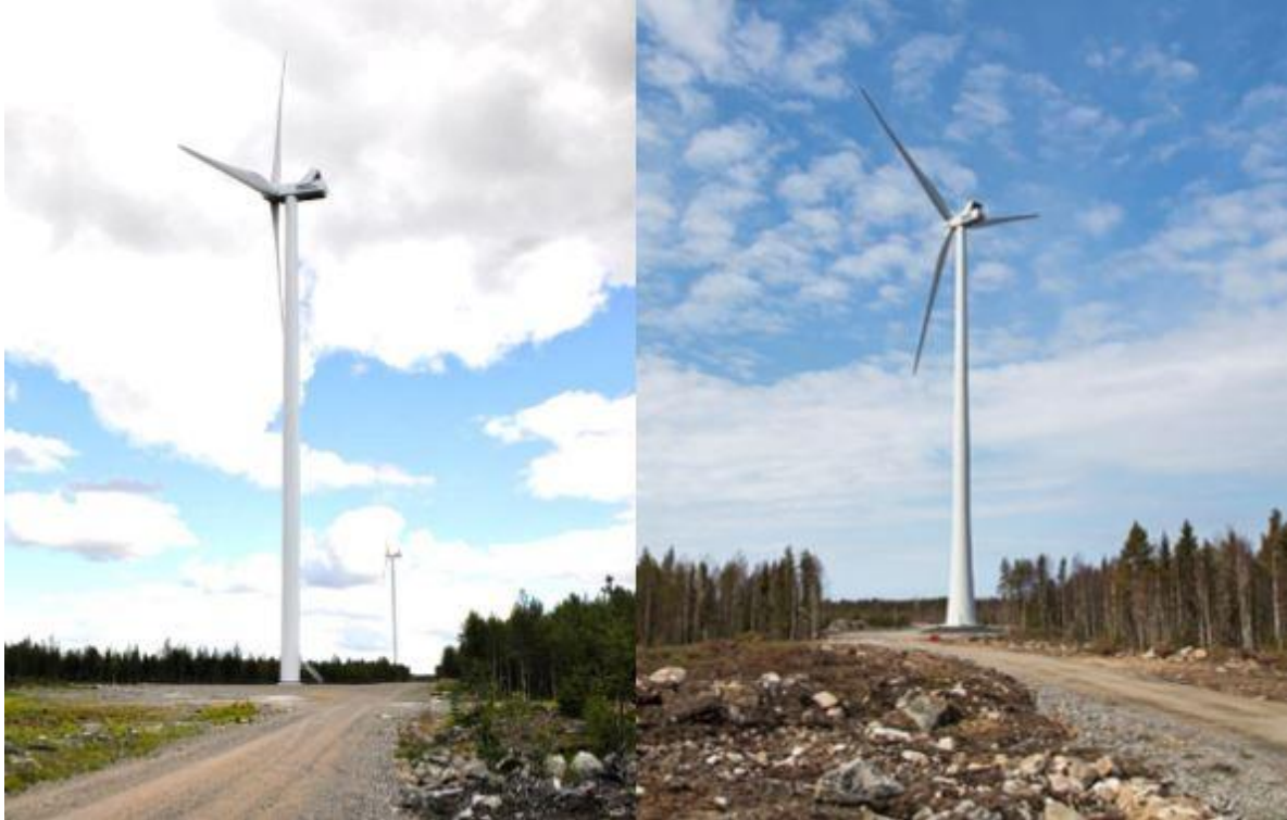
Kuva 5.2 Vasemmalla on esimerkki teräslieriötornista ja oikealla hybriditornista (FCG).
