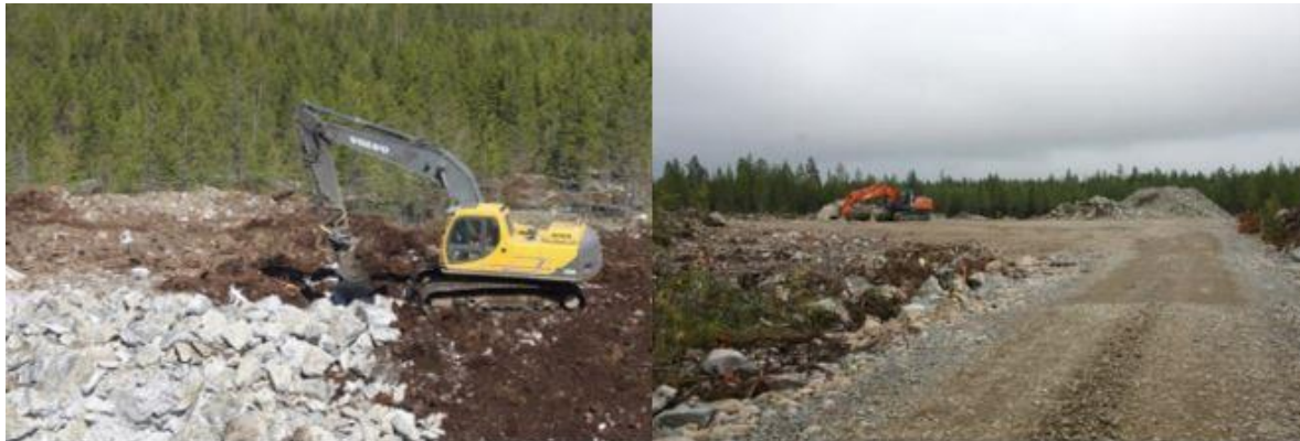
Kuva 5.11 Tuulivoima-alueen rakentaminen alkaa huoltoteiden ja pystytysalueiden rakentamisella (FCG).
