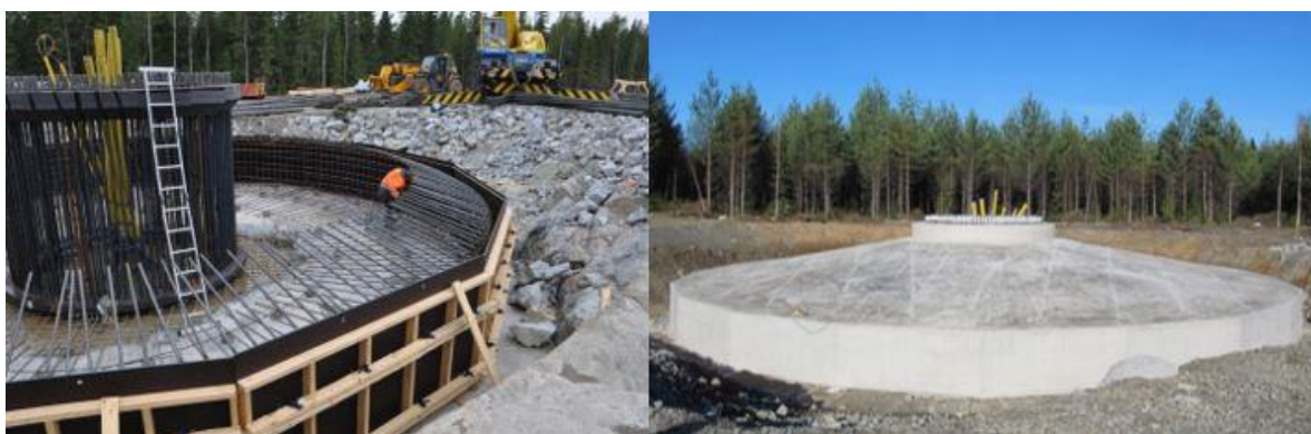
Kuva 5.13 Tuulivoimalan perustusten rakentamista (FCG).
