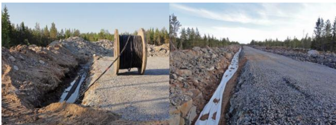
Kuva 5.12 Maakaapelit upotetaan huoltoteiden yhteyteen (FCG).
