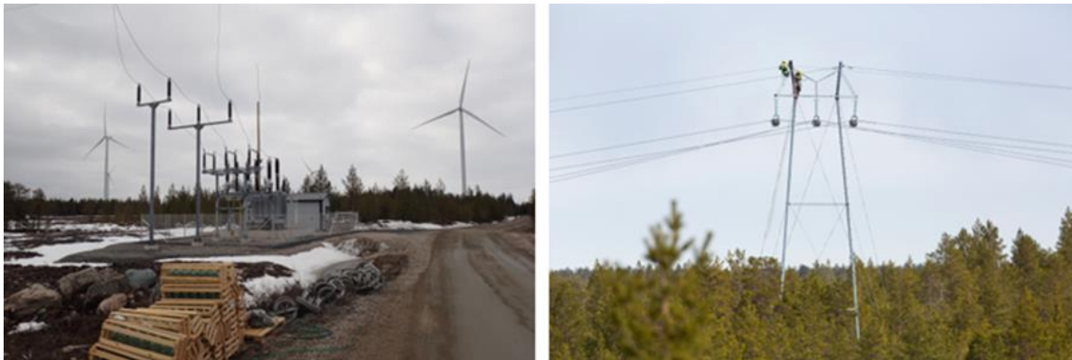
Kuva 5.16 Sähköaseman ja voimajohdon rakentamista (kuvat: FCG).
