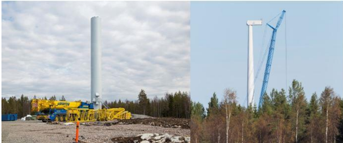
Kuva 5.14 Tuulivoimalan kokoamista (FCG).
