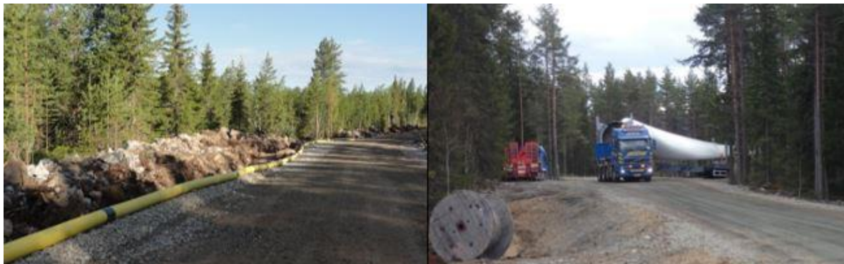
Kuva 5.6 Vasemmalla esimerkki tuulivoima-alueen rakennus- ja huoltotiestä. Oikealla tuulivoimalan osia kuljetetaan erikoiskuljetuksina (FCG).
