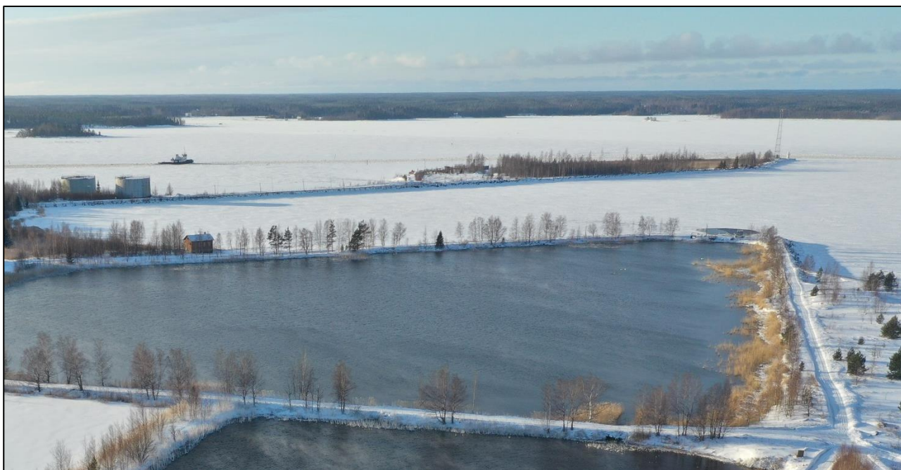
Kuva 67. Ilmakuva hankealueesta kohti aallonmurtajaa (Envineer Oy, 2022).
