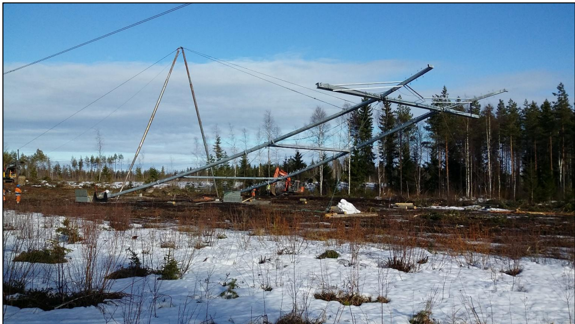
Kuva 3-7. Voimajohtopylvään pystytys.
