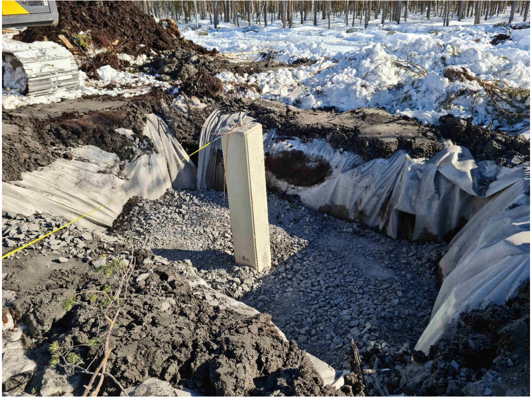
Kuva 3-4. Pylvään perustuselementin asentaminen.
