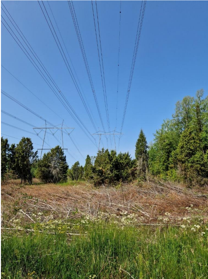
Kuva 3-8. Esimerkki valikoivasta raivauksesta.
