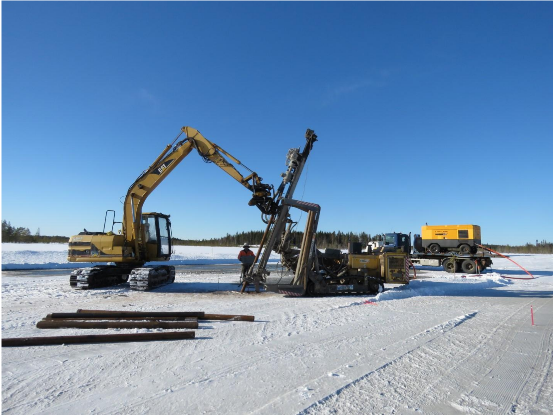
Kuva 3-6. Porapaaluperustuksen tekoa suoalueella, jossa työalue on jäädytetty.
