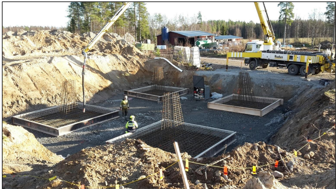
Kuva 3-5. Vapaasti seisovan pylvään perustuksen pohjatöitä.
