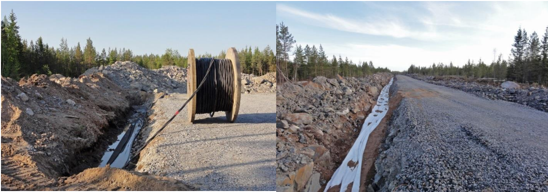
Kuvapari 5.10. Maakaapelit upotetaan huoltoteiden yhteyteen. (Kuvat: Ville Suorsa / FCG)
