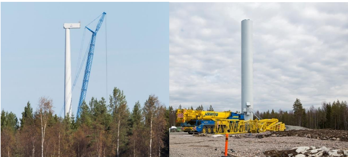
Kuvapari 5.12. Tuulivoimalan kokoamista. (Kuvat: Ville Suorsa / FCG)
