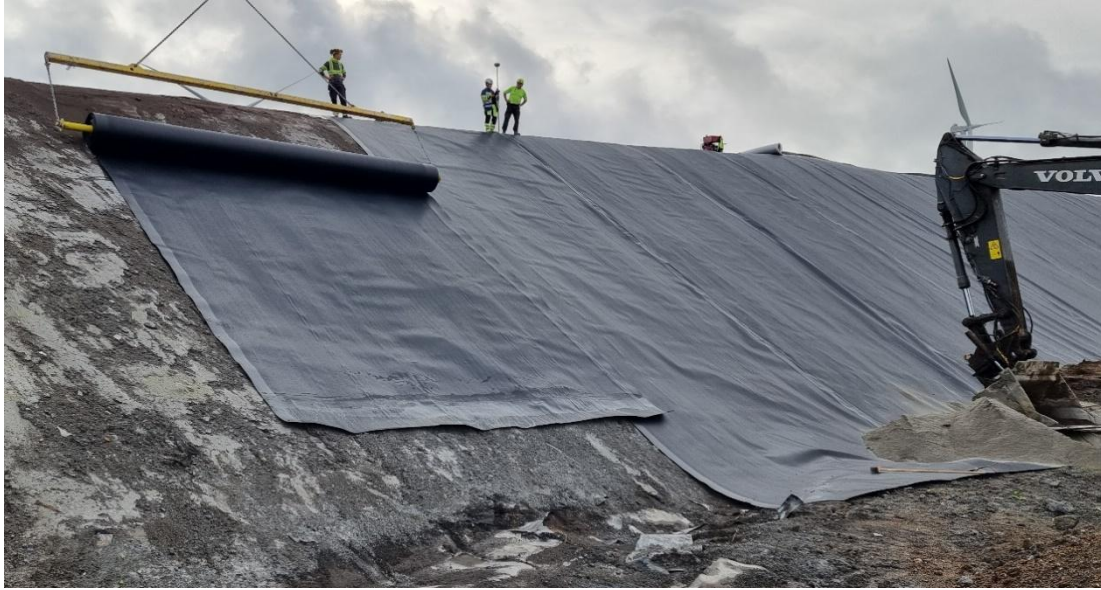
Kuva 17. Fortumin ja Erityisjätteen Suojakalvon levitys.
