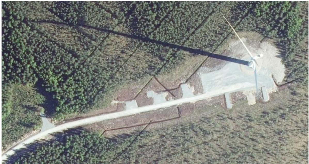
Kuva 8. Esimerkki juuri valmistuneen tuulivoimalan asennusalueesta. Ilmakuvan lähde: Maanmittauslaitos, avoimet aineistot 2022.
