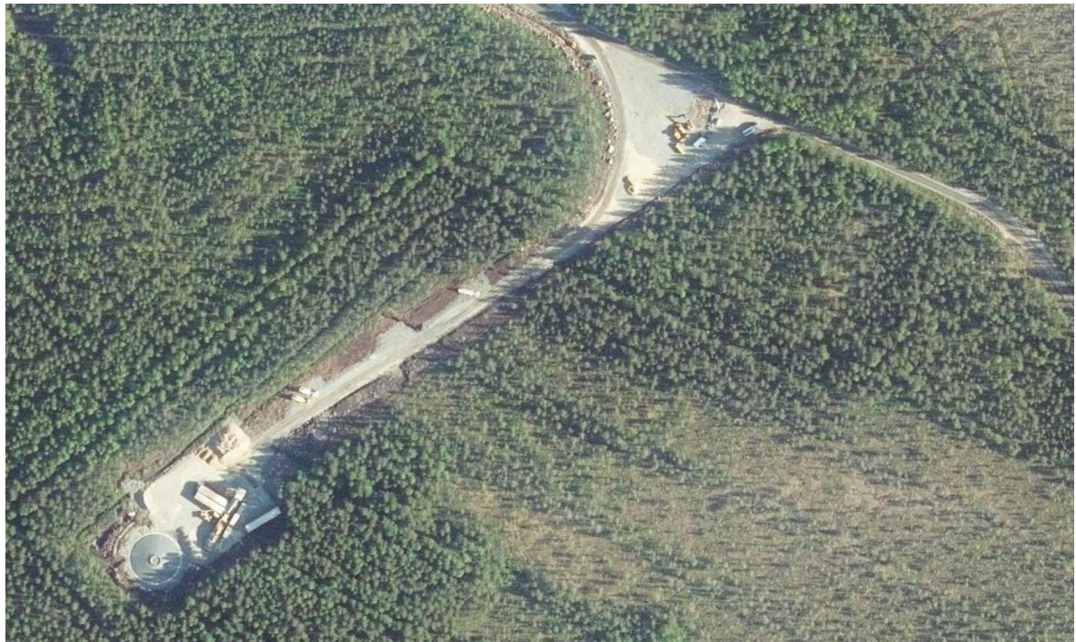
Kuva 7. Esimerkki tuulivoimalan rakennustyömaasta. Ilmakuvan lähde: Maanmittauslaitos, avoimet aineistot 2022.
