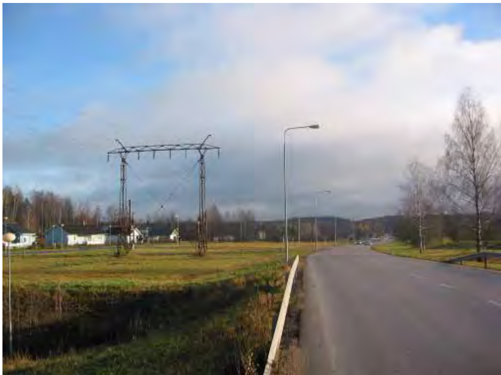
Kuva 35. Riihimäellä nykyinen 2x110 kV voimajohto näkyy läheisiltä pihapiireiltä ja Oravankadulta.
