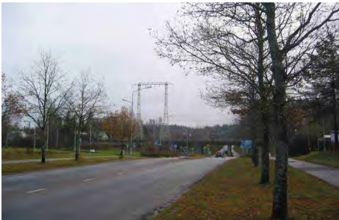
Kuva 28. Pohjoiseen menevän pääradan ylitys Riihimäellä.
