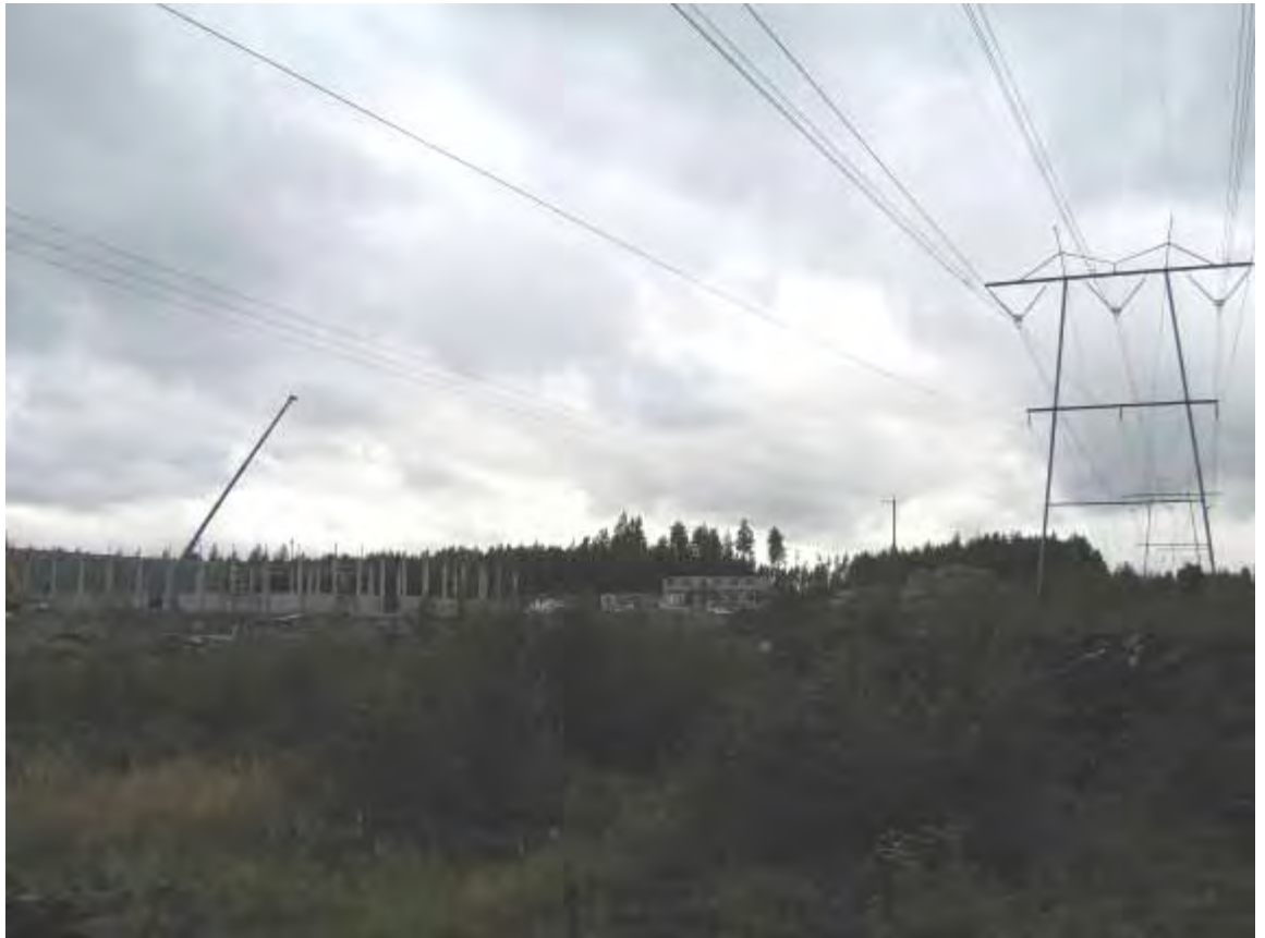
Kuva 29. Uutta teollisuuslaitosta rakennetaan Forssan Hirsikorvessa nykyisten voimajohtojen vierelle.
