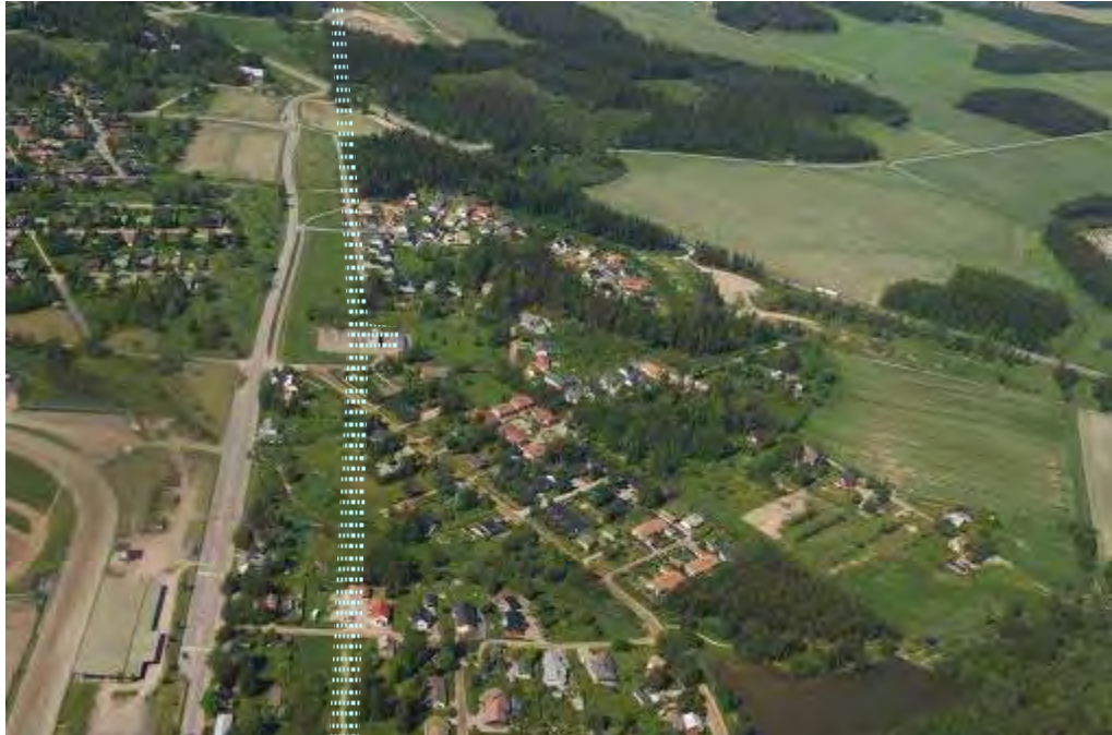
Kuva 34. Nykyinen 2x110 kV voimajohto taajamarakenteen sisällä Riihimäellä.
