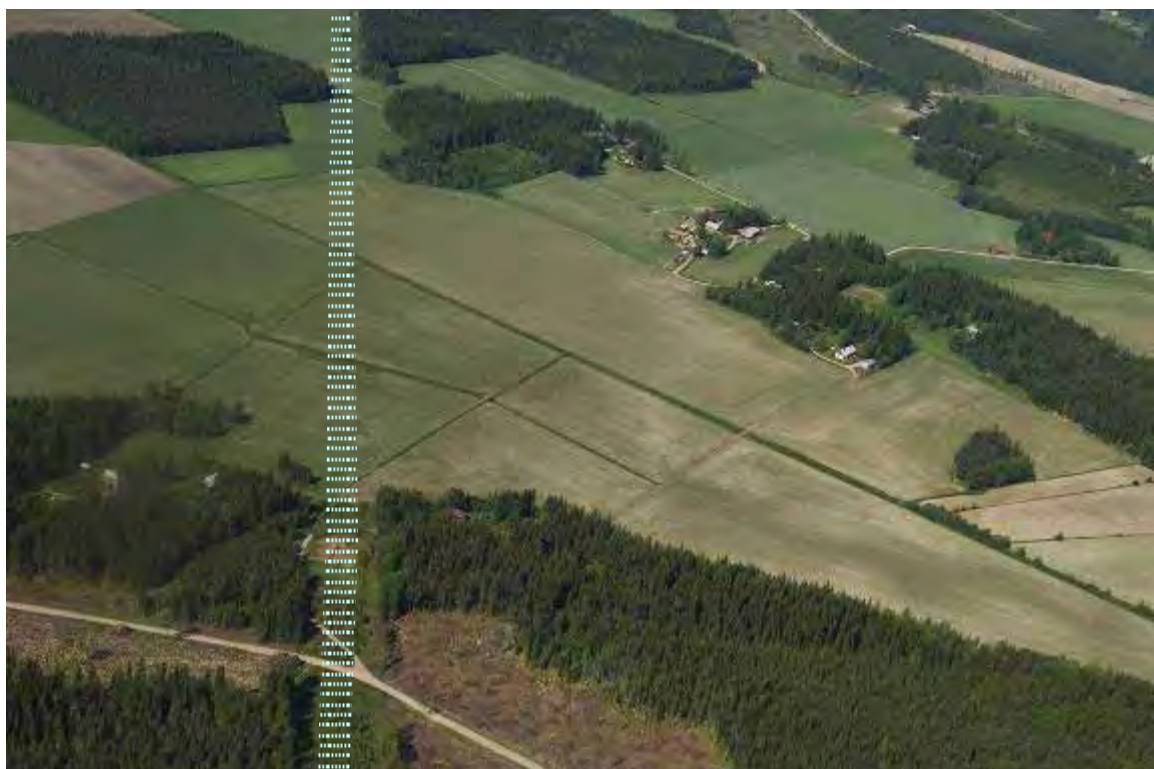
Kuva 36. Viistoilmakuva Hausjärven Vehkaojalta, missä nykyinen voimajohto ylittää noin 1,5 kilometrin levyisen peltoaukean.
