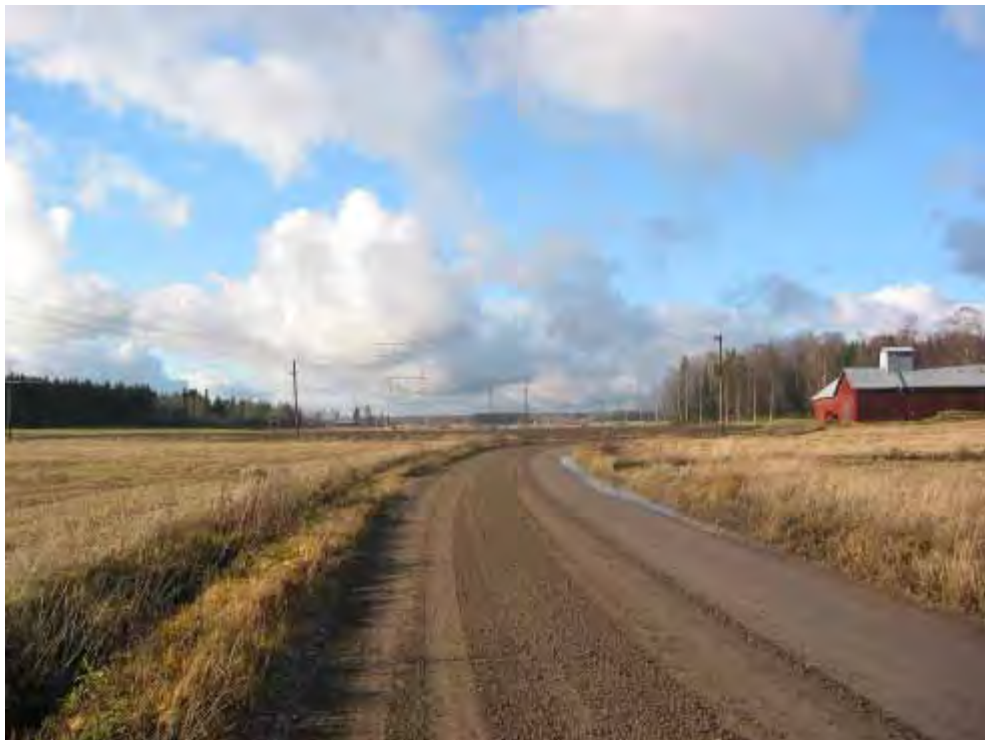
Kuva 33. Visuaalisella vyöhykkeellä 3 johtorakenteet alkavat sulautua kaukomaisemaan
