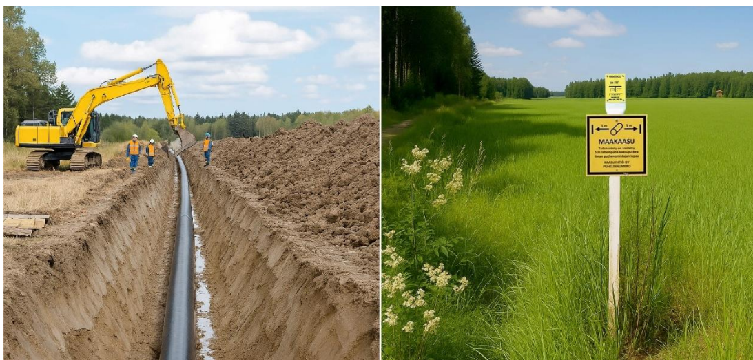
Kuva 3-7. Putkikaivanto ja putken lasku pellolla, sekä pelto asennus- ja viimeistelytyöiden jälkeen seuraavana vuonna kuvattuna.
