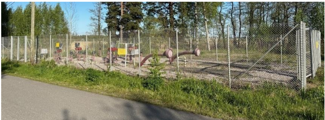
Kuva 3-3. Venttiili-asema.
