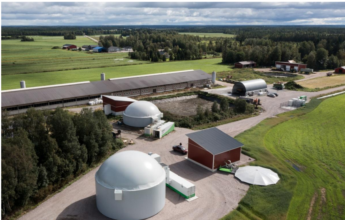
Kuva 9. Etualalla näkyy Wekas Oy:n biokaasulaitos ja sen takana Bull Team Oy:n biokaasulaitos.
