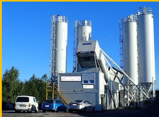
Betoniasema (YIT Infra Oy)
