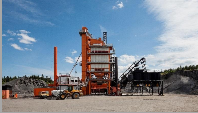
Asfalttiasema (YIT Infra Oy)
