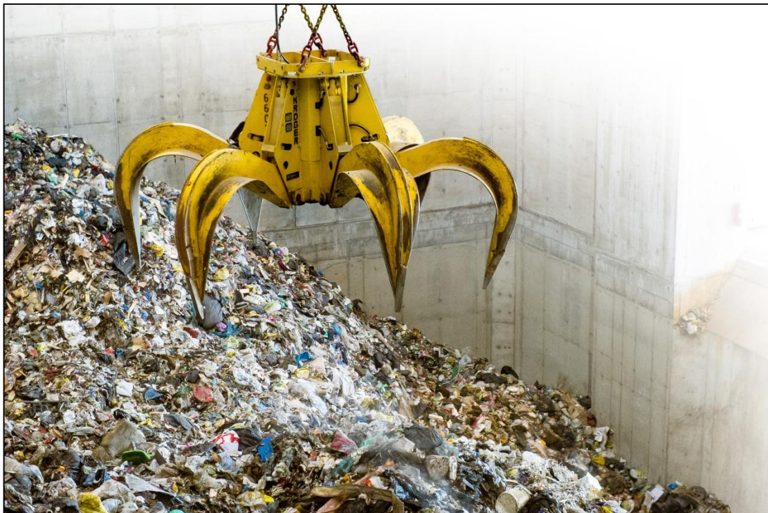
Kuva 3-4. Jätebunkkeri ja jätettä syöttävä kahmari.
